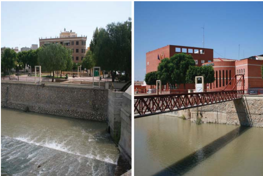
Figura 11. Rojales. Fotografías de nuevos espacios urbanos y nuevos equipamientos construidos tras el encauzamiento del río Segura a su paso por el centro urbano.
