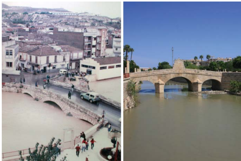
Figura 10. Rojales. Fotografías del cauce del río Segura a su paso por el casco urbano. Crecida del río a su paso por el puente Carlos III (izquierda). Imagen del puente Carlos III año 2013 (derecha).
