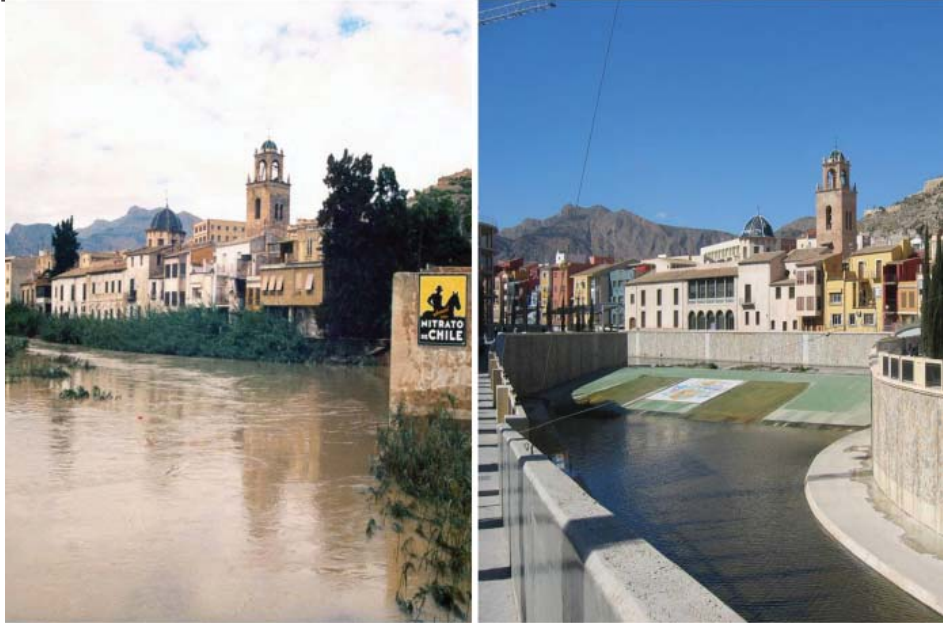
Figura 7. Orihuela. Fotografías del cauce del río Segura a su paso por el casco urbano en el Azud de las lavanderas. Comparativa imagen 1987 (inundación previa al Plan de Avenidas) y 2005 (tras las intervenciones de remodelación del cauce)
