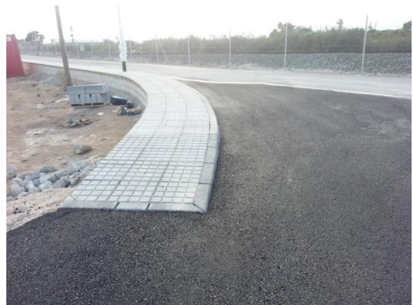
Figura 6: Final de acera pavimentada enrasada con la calzada. Fuente: Proyecto de urbanización del vial de acceso al colegio público Puig Jover.
