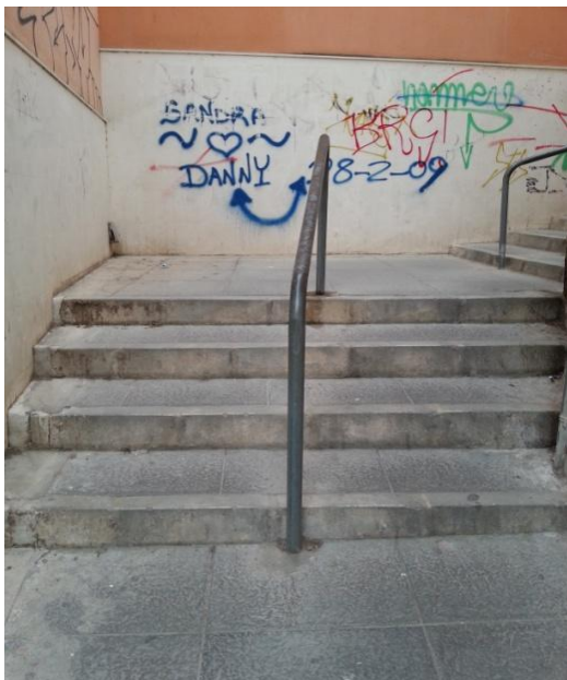
Figura 49: Primer tramo de escaleras C/San Roque. Fuente: Autora.
