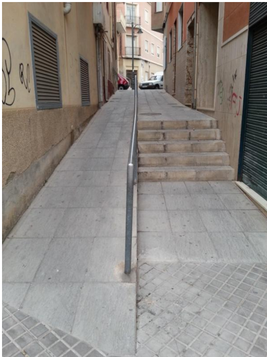
Figura 41: Rampa C/San Pancraccio. Fuente: Autora.
