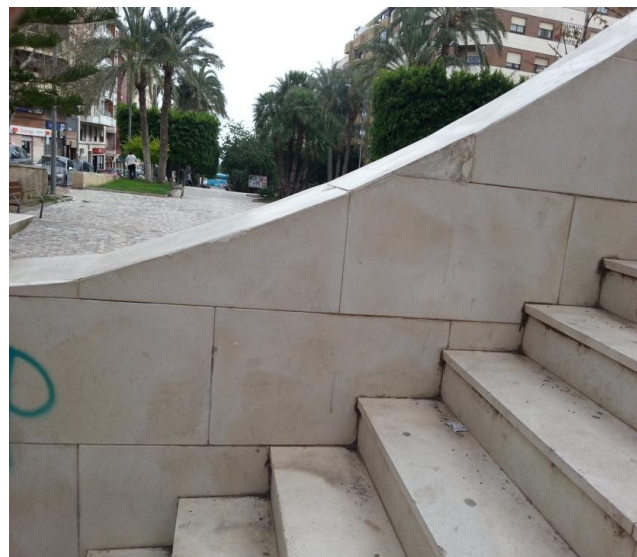
Figura 62: Pasamanos escalera Paseo Fontenay. Fuente: Autora.
