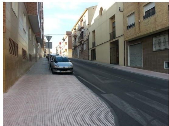
Figura 2: Acera calle Reverendo Pascual Martínez. Fuente: Autora.
