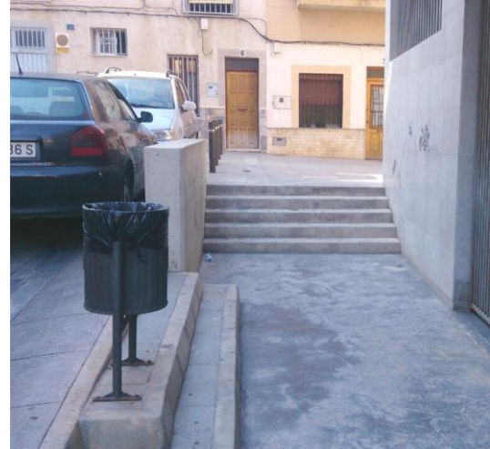
Figura 56: Vista frontal de la escalera junto a la calzada. Fuente: Autora.
