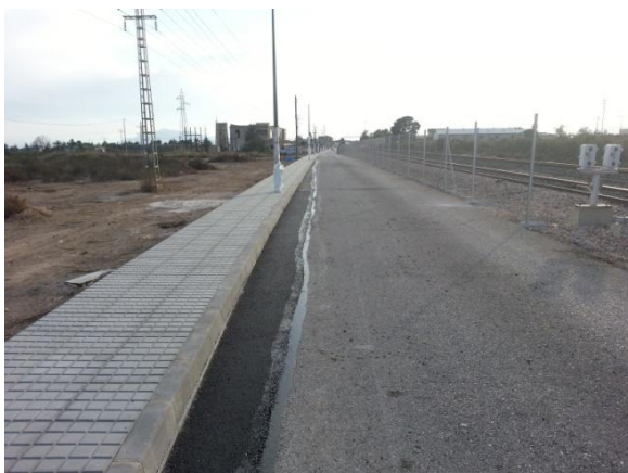
Figura 5: Estado actual del vial de acceso del barrio La Estación al colegio Puig Jover. Fuente: Proyecto de urbanización del vial de acceso al colegio público Puig Jover.
