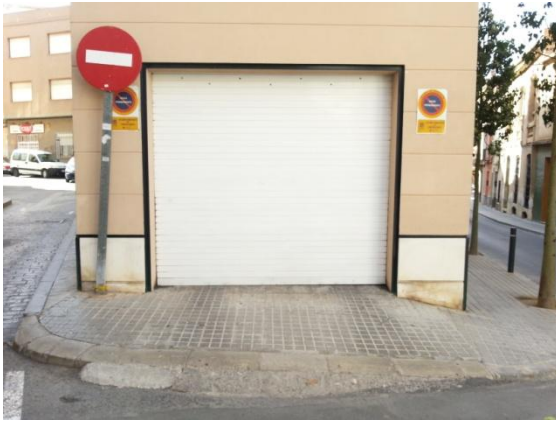
Figura 35: Vado vehicular tipo 1. Invade la banda libre peatonal y parcialmente la calzada. Fuente: Autora.
