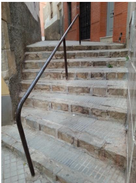
Figura 51: Tercer tramo de escaleras C/San Roque. Fuente: Autora.
