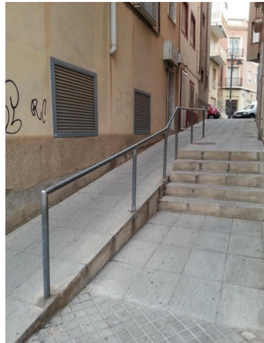
Figura 42: Rampa C/San Pancraccio. Fuente: Autora.
