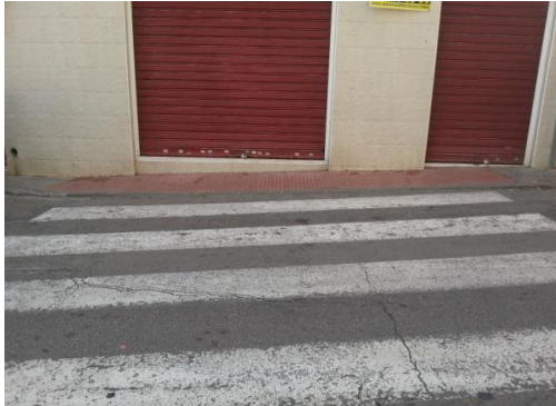
Figura 39: Vado peatonal tipo 1. Invade la banda libre peatonal. Fuente: Autora.
