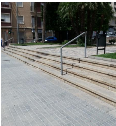
Figura 63: Escalones acceso Paseo Fontenay. Fuente: Autora.
