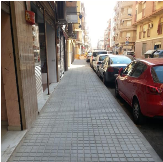
Figura 3: Estado actual de la acera calle Pintor Velázquez. Fuente: Autora.
