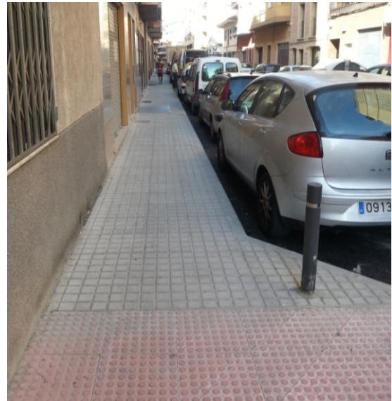
Figura 4: Estado actual de la acera calle Luis Vives. Fuente: Autora
