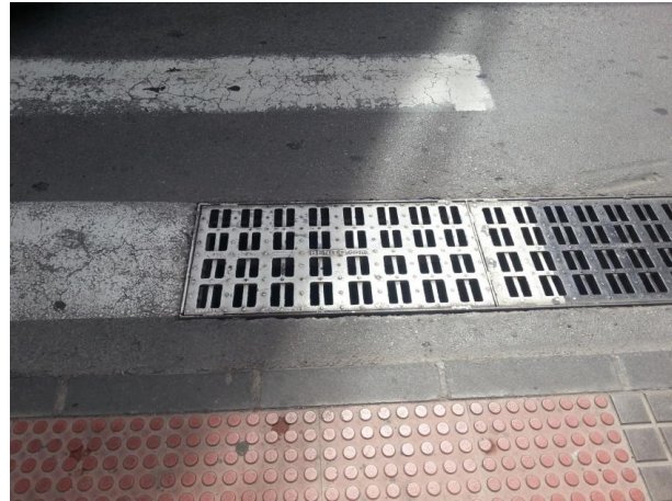
Figura 25: Rejilla en calzada ubicada en un paso de peatones. Fuente: Autora.
