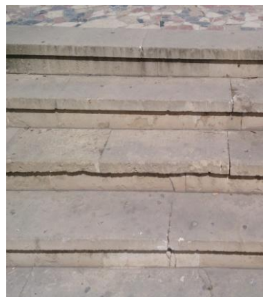
Figura 64: Escalones acceso Paseo Fontenay. Fuente: Autora.
