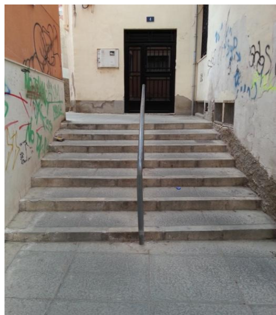
Figura 50: Segundo tramo de escaleras C/San Roque. Fuente: Autora.
