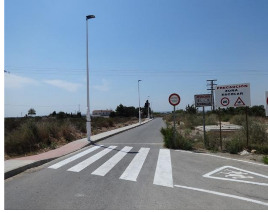
Figura 8: Señalización de acera con marcas viales en la calzada. Fuente: Proyecto de urbanización del vial de acceso al colegio público Puig Jover.
