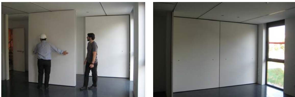
Imagen 4. Tabiques móviles acústicos.
