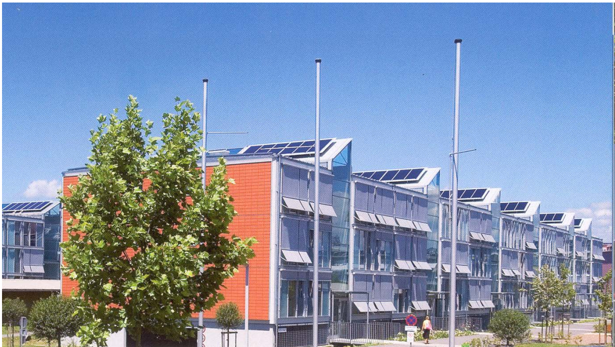
Imagen 14. Sistema de energía solar.
