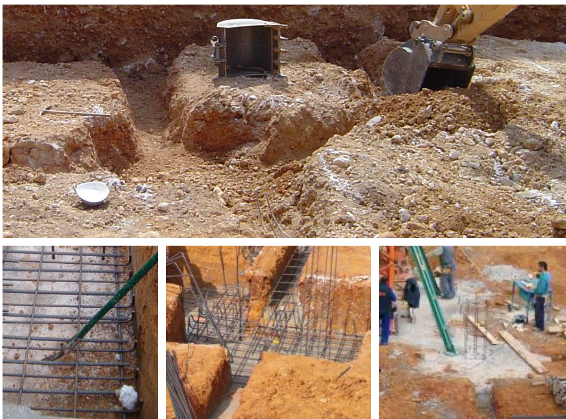
Figura 7. Imágenes reales del proceso constructivo.
