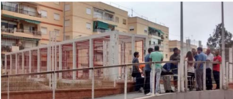
Figura 9. Vista general de la estructura en San Gabriel.
