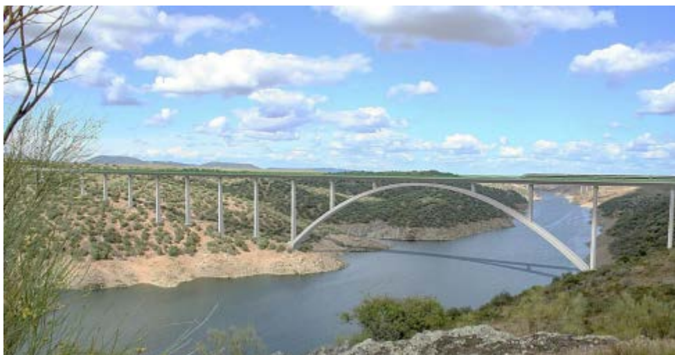
Figura 1. Perspectiva general-Visita puente sobre el Rio Tajo. Cáceres
