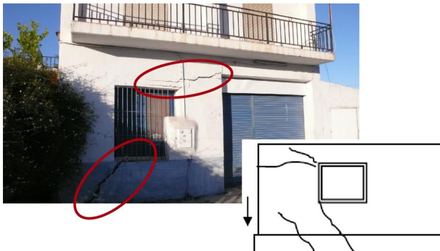
Figura 8. Fotografía de unas fisuras en una vivienda mediante una tablet , resaltando la zona fisurada sobre la pantalla y sobreponiendo el esquema del patrón patológico que más se ajusta
