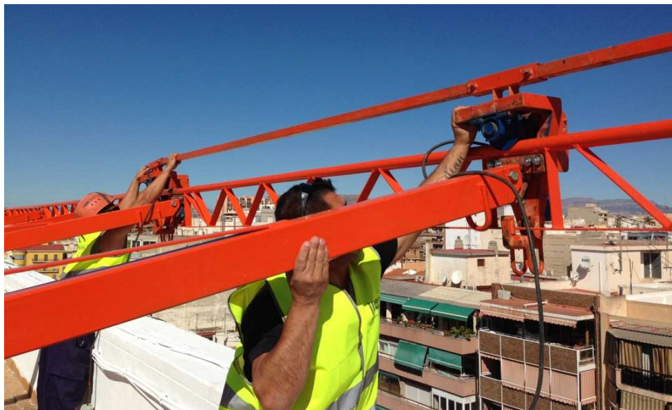
Figura 21. Colocación de perfil metálico. Fuente: Elaboración propia.
