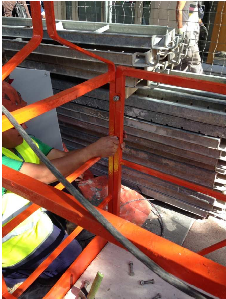
Figura 26.b. Montaje de plataforma. Fuente: Elaboración propia.
