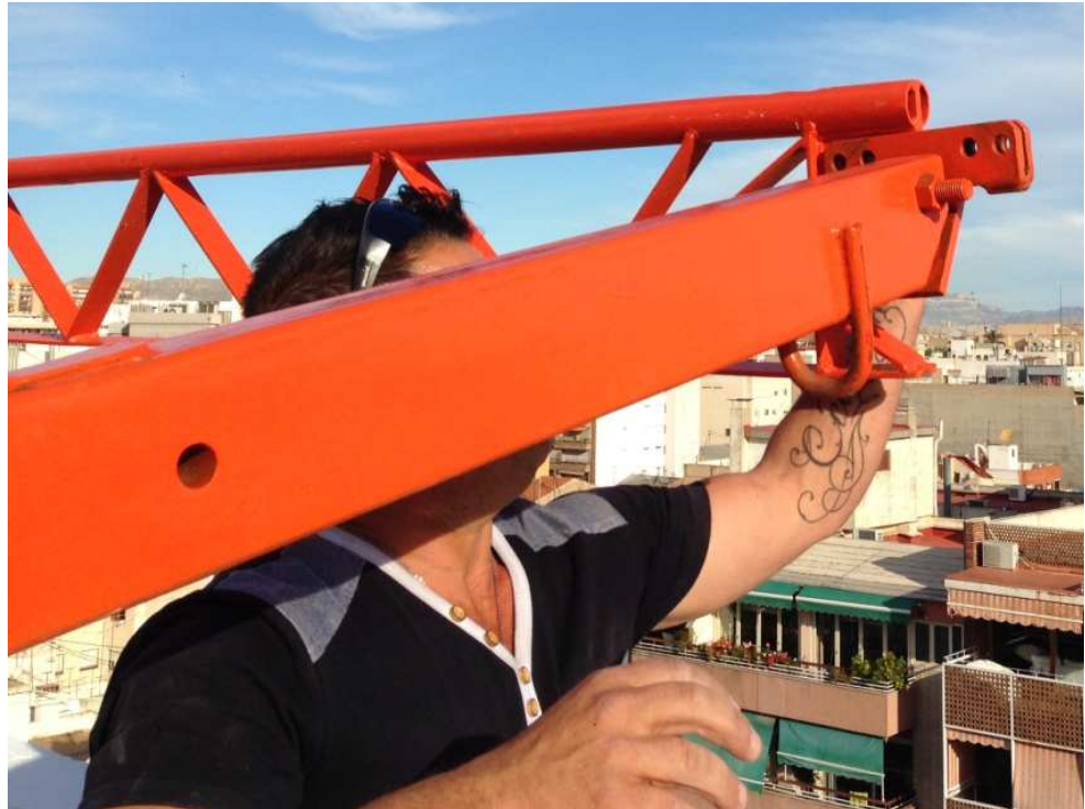
Figura 18. Unión de tramo de raíl con cabezal. Fuente: Elaboración propia.
