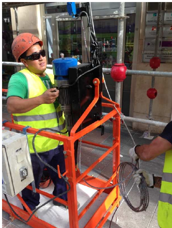
Figura 31. Colocación de aparejo de elevación en la plataforma. Fuente: Elaboración propia.
