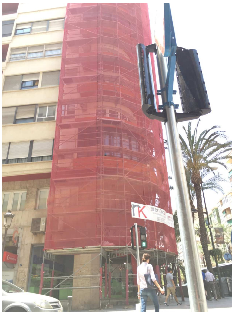
Figura 34.a. Andamio apoyado. Fuente: Elaboración propia.
