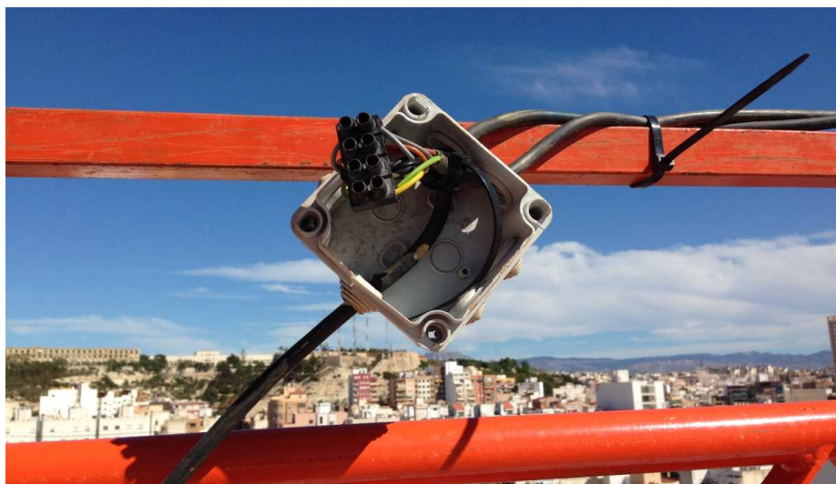
Figura 22.b. Conexión eléctrica de los carros. Fuente: Elaboración propia.
