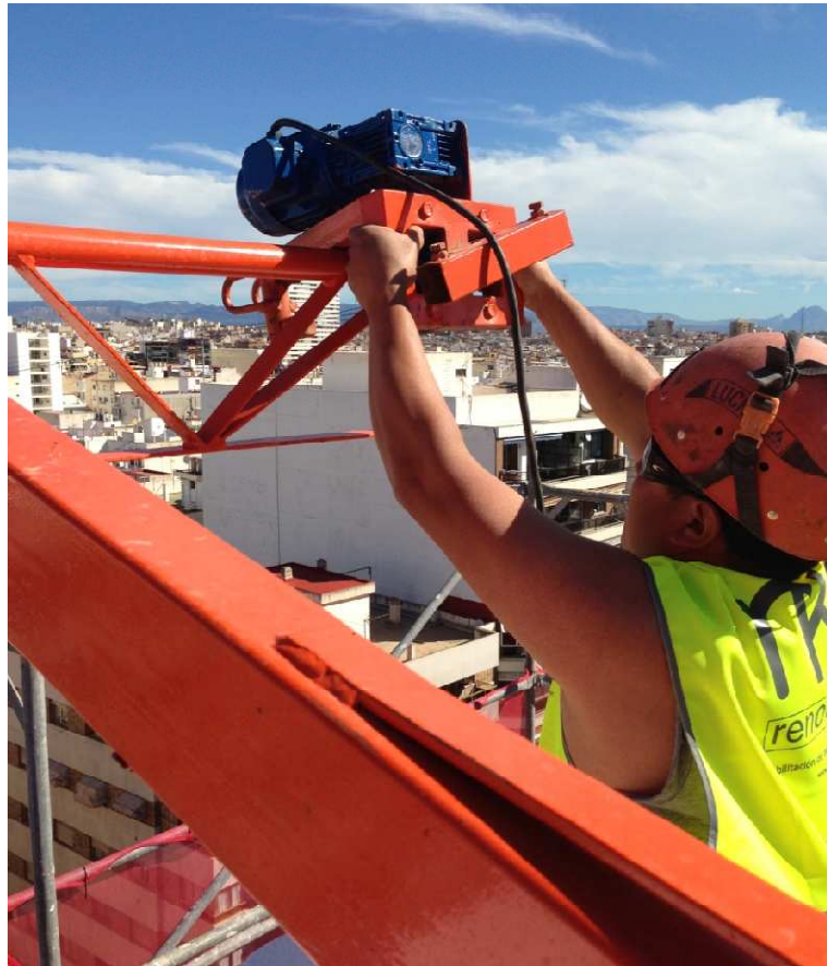
Figura 20.b. Colocación de los carros en el tramo de raíl. Fuente: Elaboración propia.
