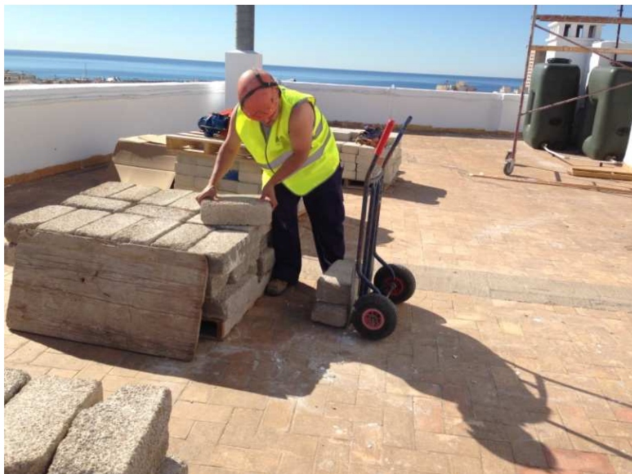
Figura 25.a. Carga de placas de contrapeso en carretilla de mano. Fuente: Elaboración propia.
