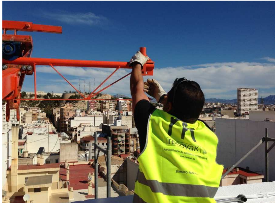
Figura 23. Colocación de los topes de raíl. Fuente: Elaboración propia.
