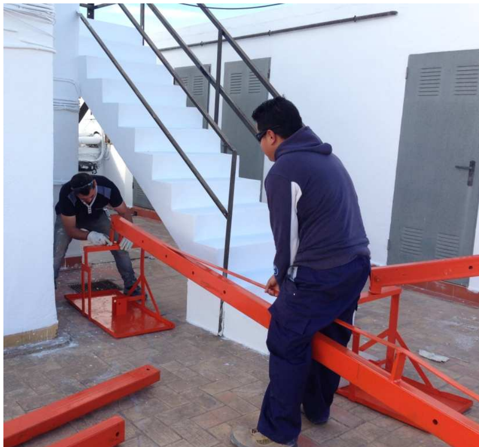
Figura 15. Colocación de pescante en la cesta. Fuente: Elaboración propia.
