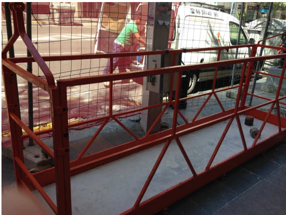
Figura 26.a. Montaje de plataforma. Fuente: Elaboración propia.
