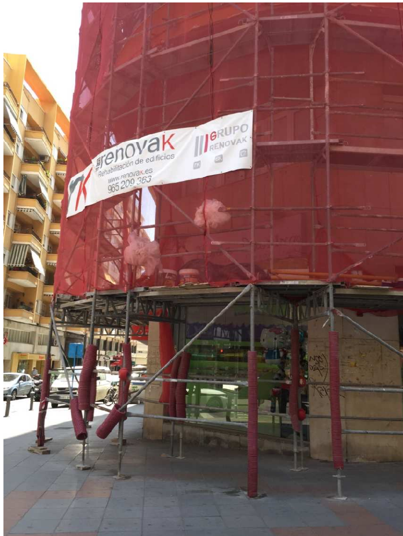
Figura 34.b. Andamio apoyado. Fuente: Elaboración propia.
