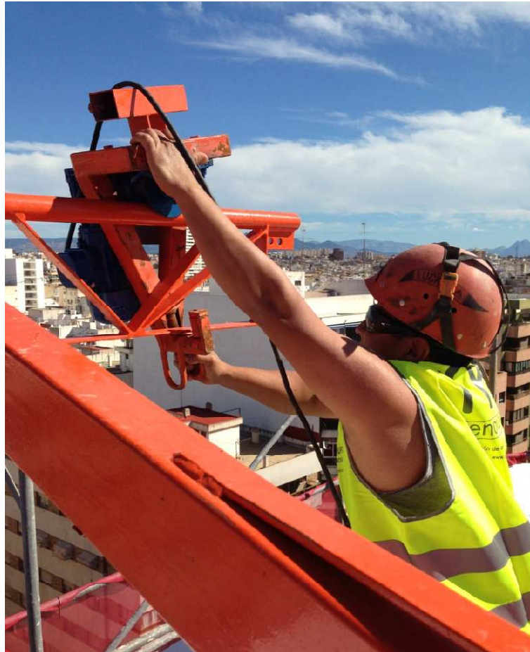
Figura 20.d. Colocación de los carros en el tramo de raíl. Fuente: Elaboración propia.
