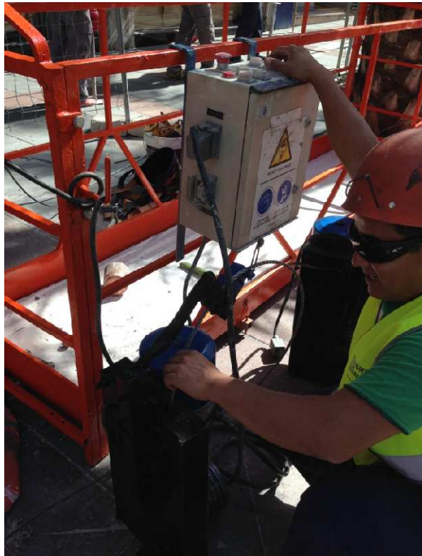
Figura 30. Introducción de cables al aparejo elevador. Fuente: Elaboración propia.
