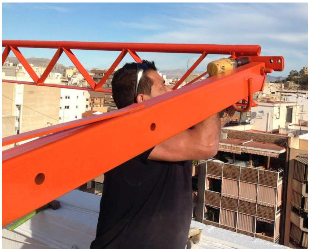
Figura 19. Atornillado mediante llave de impacto. Fuente: Elaboración propia.
