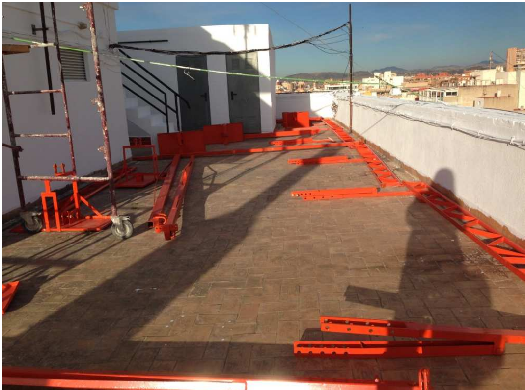
Figura 14. Replanteo de elementos sobre cubierta. Fuente: Elaboración propia.
