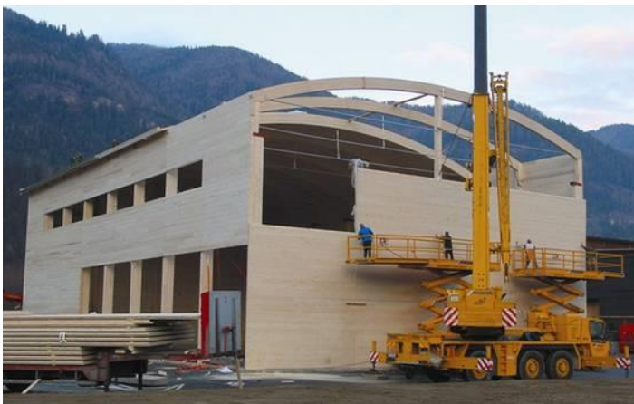
Fig. 2.19. Montaje de los paneles en el almacén de la empresa KLH (Fuente: http://www.klh.at/typo3temp/pics/286f99b266.jpg )
