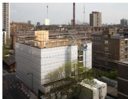
Fig. 2.14. Fase de estructura en la planta 7 (Fuente: http://www.klhuk.com/media/2030/stadthaus04.jpg )
