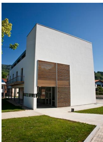
Fig. 2.24. Ayuntamiento de Izkaltegieta totalmente terminado (Fuente: http://www.egoín.com/galeria_fotos/galeria-obras-singulares-ikaztegieta.php )
