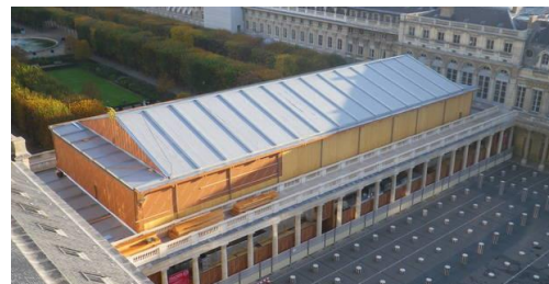
Fig. 2.30. Ampliación del teatro Éphémère con paneles KLH (Fuente: http://www.klh.at/typo3temp/pics/a6dd221f5d.jpg )
