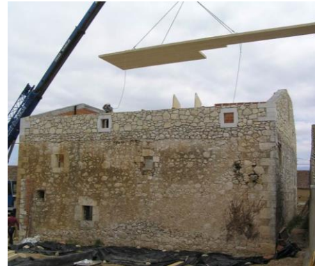
Fig. 2.27. Montaje de paneles de forjado en obra de rehabilitación (Fuente: http://3.bp.blogspot.com/-JaPq7FA5blo/UUhF-OfGRTI/AAAAAAAAALU/NAUCsZNOdfI/s1600/20130320_rehb+riahuellas+BG_14.jpg )
