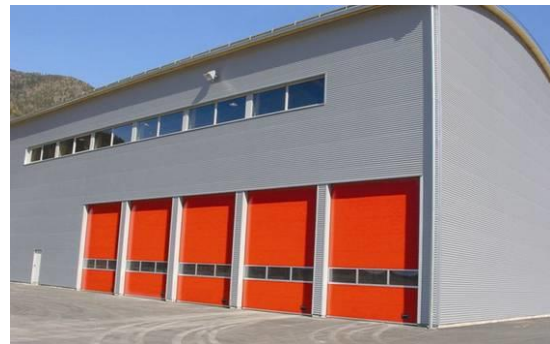
Fig. 2.21. Almacén de la empresa KLH totalmente terminado (Fuente: http://www.klh.at/typo3temp/pics/faac6cc1d7.jpg )
