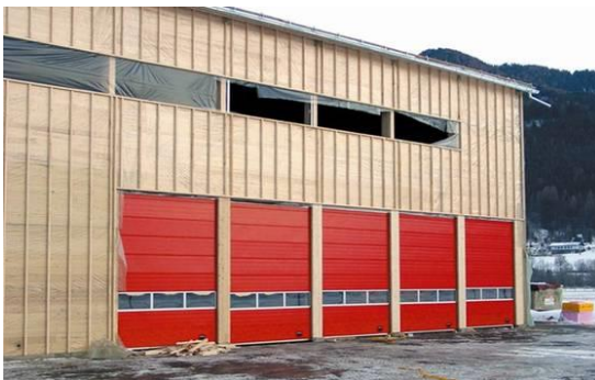
Fig. 2.20. Almacén de la empresa KLH sin revestimiento exterior (Fuente: http://www.klh.at/typo3temp/pics/a1333214f9.jpg )
