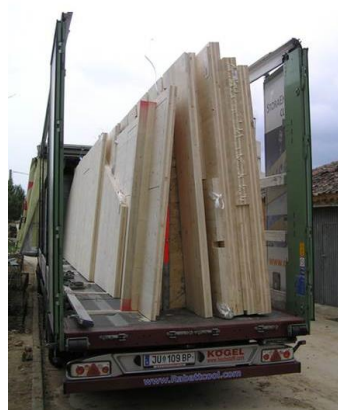
Fig. 4.8. Transporte de los paneles contralaminados mediante camión (Fuente: http://4.bp.blogspot.com/-ByhZBNNBIog/UUhF_z6PoII/AAAAAAAAAME/OaWR4a-TP9M/s1600/20130320_rehb+riahuelas+BG_19.jpg )
