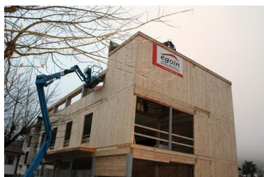
Fig. 2.25. Ayuntamiento de Izkaltegieta en fase de estructura (Fuente: http://www.egoín.com/galeria_fotos/galeria-obras-singulares-ikaztegieta.php )
