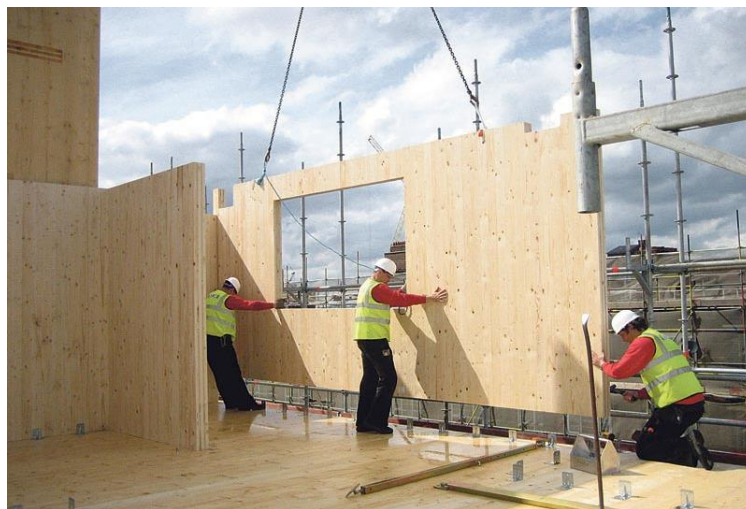
Fig. 4.10. Instalación mediante grúa y trabajadores de un panel vertical de madera contralaminada (Fuente: http://www.internationaltradenews.com/klh_massivholz_gmbh/portrait/ )
