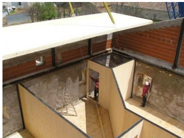
Fig. 2.28. Montaje de particiones y cerramientos con paneles en obra de rehabilitación (Fuente: http://2.bp.blogspot.com/-eTO6cSKBmPA/UUhF9IQbvAI/AAAAAAAAALA/2sKo44Xg3As/s1600/20130320_rehb+riahuellas+BG_12.jpg )
