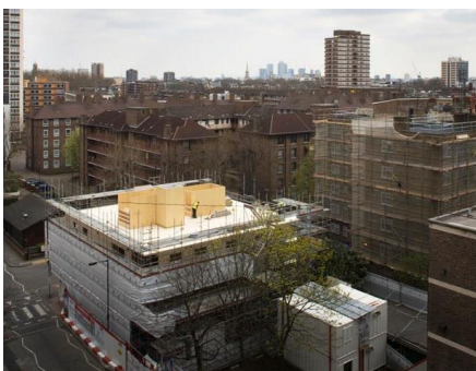
Fig. 2.13. Fase de estructura en la planta 4 (Fuente: http://www.klhuk.com/media/2024/stadthaus03.jpg )
