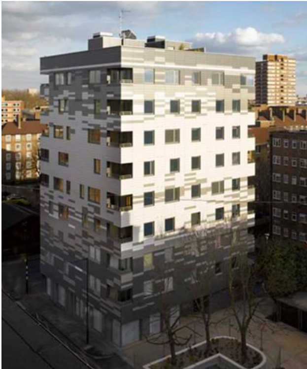
Fig. 2.10. Edificio Murray Grove totalmente construido (Fuente: http://www.waughthistleton.com/project.php?name=murray )
