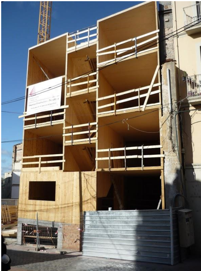
Fig. 2.15. Edificio Cavallers estructura hasta planta 4 (Fuente: https://lh4.googleusercontent.com/-dhH4J5wDTXs/UW5Wj1Ma5VI/AAAAAAAAAHw/3ZtOb5Humns/w601-h801-no/P1100052.JPG )
