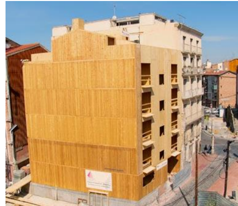
Fig. 2.16. Edificio Cavallers en fase de estructura (Fuente: https://lh4.googleusercontent.com/--yRSTrRQHo/VAI4X_P8y3I/AAAAAAAAAgo/b4U0VPu59HU/w494-h371-no/a3.jpg )
