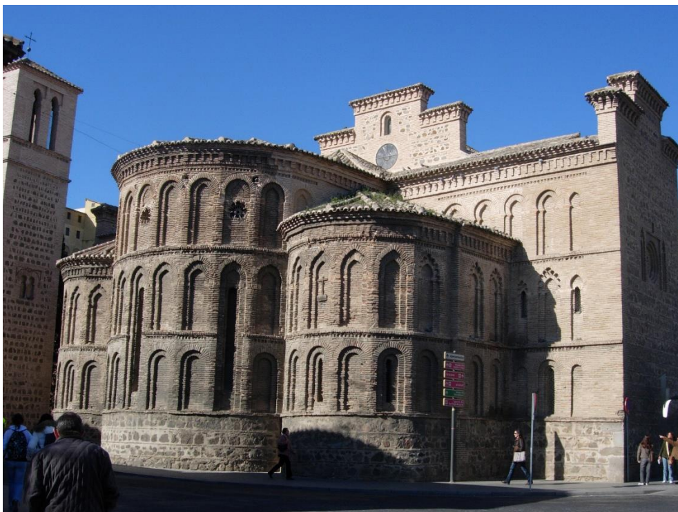
Fig. 9. Exterior de Santiago de Arrabal
