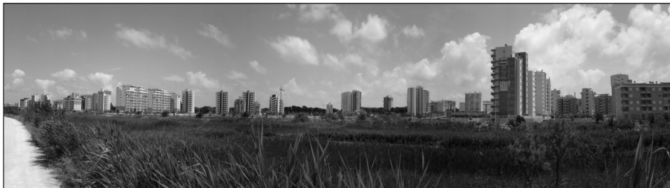
FIGURA 2. Impacto paisajístico de los edificios sobre los alrededores del río Segura*
