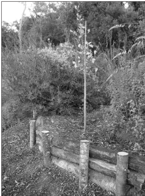
FIGURA 3: Roble y su estructura para retener el agua del talud
