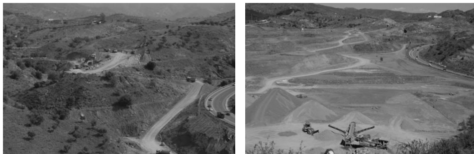
FIGURA 5. Desmontes realizados. 2007 y 2009
