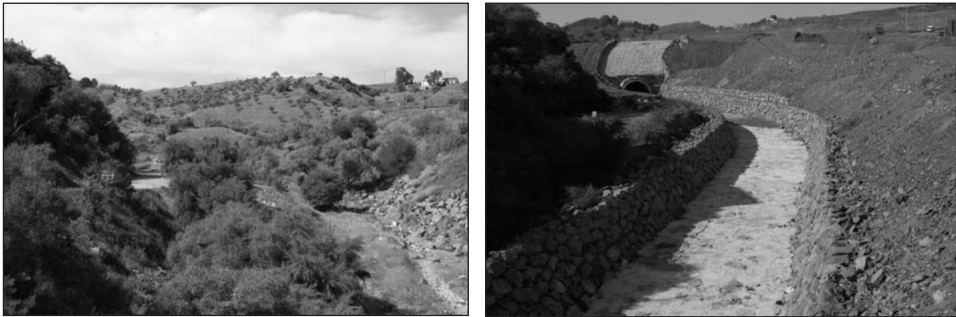
FIGURA 3. Comparación del cauce del arroyo del Carnicero. 2007 y 2009
