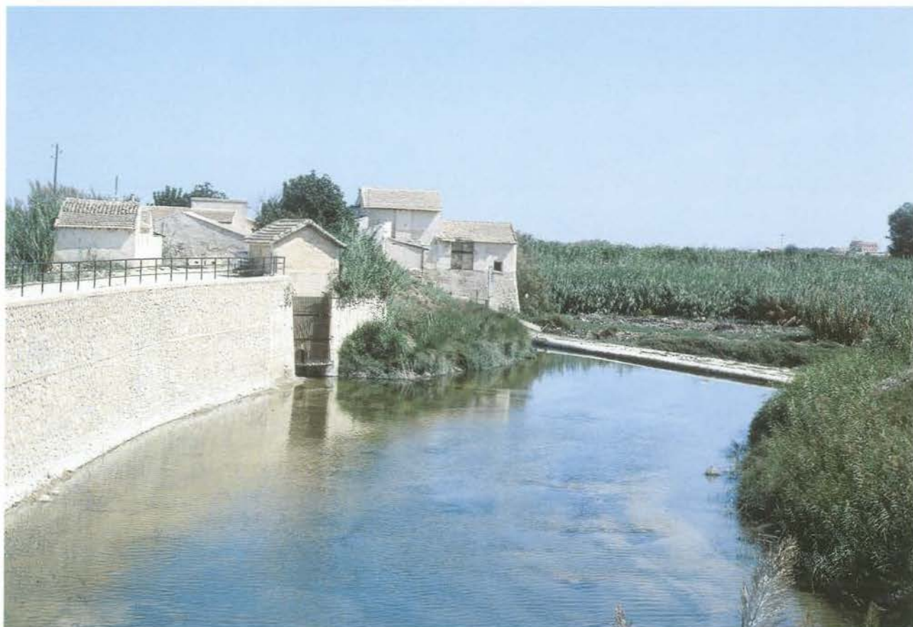
Figura 11. Detalle de la toma de agua en una de las acequias que parten del Azud de Alfeitamí. Esta infraestructura sufrió numerosas modificaciones a lo largo del tiempo hasta quedar concluida en 1615.
