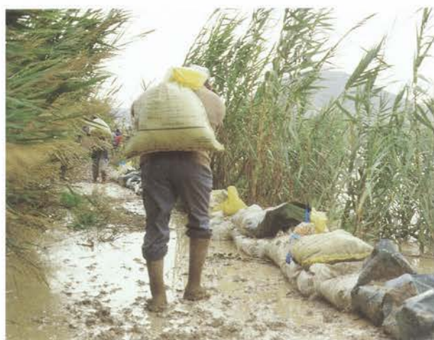
Figura 17. Los métodos de defensa ante las inundaciones siguen siendo los tradicionales. Los agricultores recrecen los bordes del río y de las acequias con sacos terreros, labor en la que participa activamente toda la comunidad. Año 1987.
