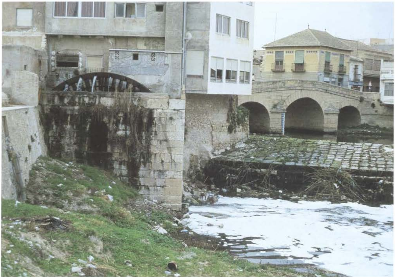
Figura 4. Las infraestructuras de riego, vitales para una comarca agrícola como la Vega Baja, quedaron desmanteladas con el terremoto. La imagen ofrece la situación actual del azud de Rojas, en las inmediaciones del viejo puente del siglo XVIII que todavía conserva su estructura original.
