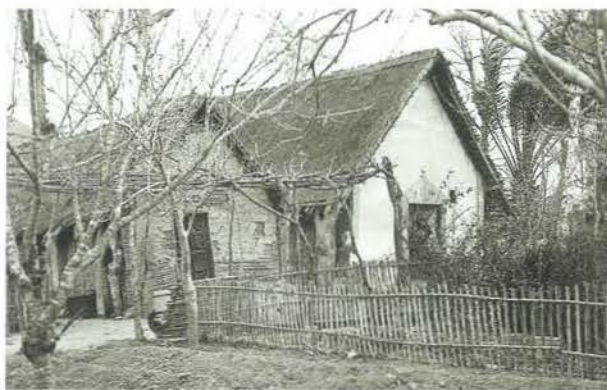
Figura 3. Después del terremoto, las barracas solucionaron la necesidad de vivienda de los habitantes que residían en los núcleos destruidos.
