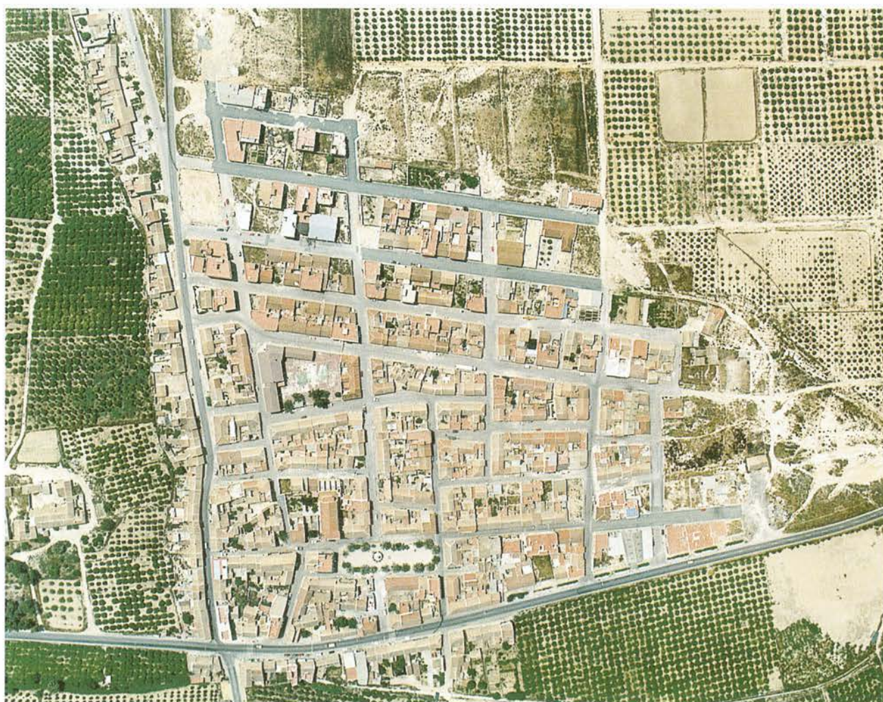
Figura 30. Algofa, como otras poblaciones de origen señorial, contó con el apoyo de su dueño territorial para la reconstrucción. En el momento del terremoto se trataba de una pequeña agrupación de casas que quedaron arrasadas por el sismo y cuya reedificación siguió los parámetros básicos de Larramendi, que aún hoy se aprecian en el callejero.
