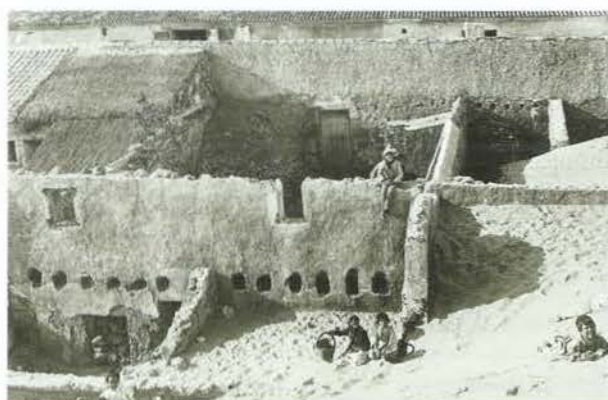
Figura 13. Detalle del tipo de vivienda diseñada por Larramendi, caracterizada por la simpleza de su estructura, puesta al descubierto al desplomarse el tejado por el peso de la arena en Guardamar del Segura.
