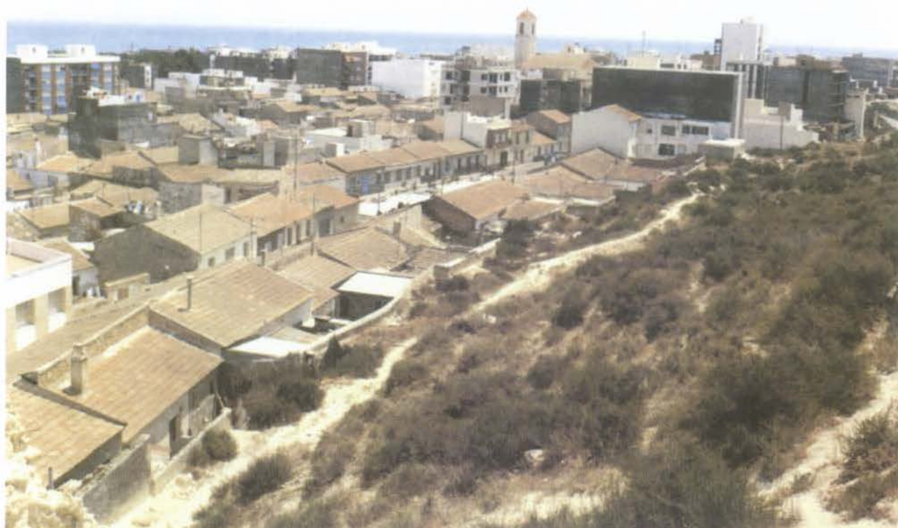
Figura 18. En los años setenta del siglo XX se agudiza el contraste entre la vieja edificación de planta baja, cuyos patios empiezan a estar cubiertos, y los edificios altos en las calles más cercanas al frente marítimo.
