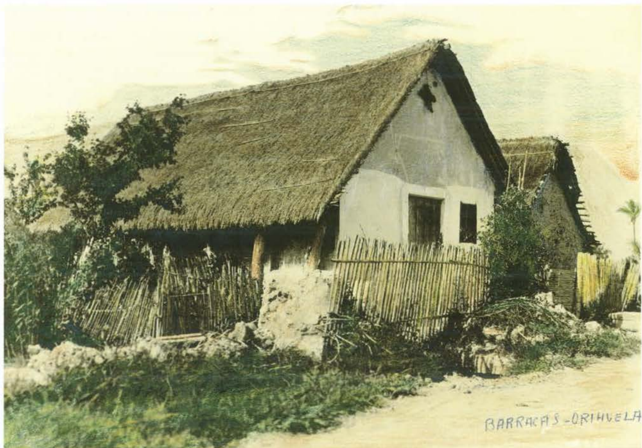
Figura 1. La barraca fue la respuesta cultural realizada por el hombre al medio geográfico donde se asienta. Su peculiar construcción responde a las condiciones del suelo, del clima y a la falta de materiales constructivos como la madera y la piedra.
