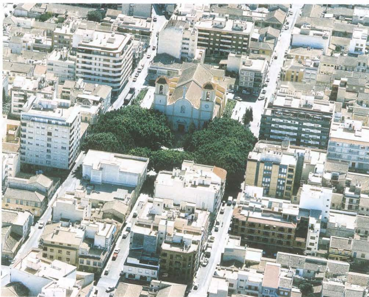
Figura 34. La imagen actual del centro de Almoradí revela el total olvido de las directrices antisísmicas de Larramendi.
