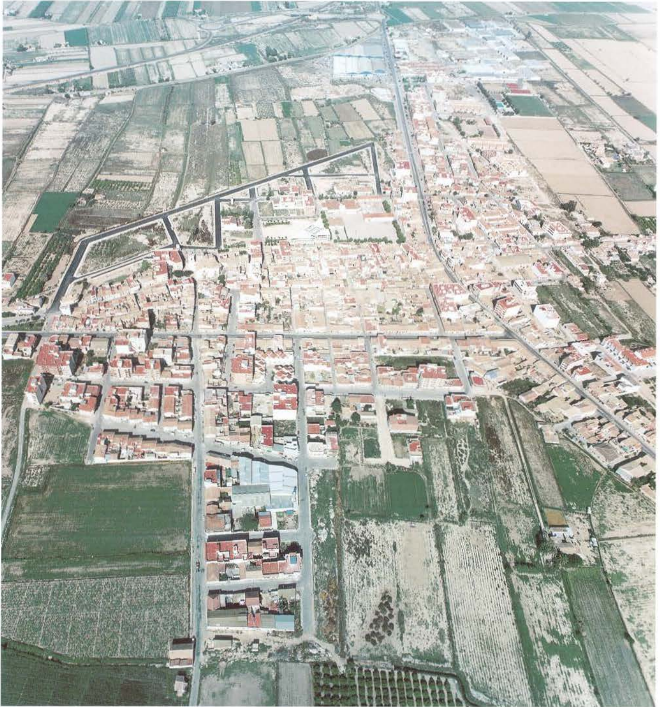
Figura 16. Catral quedó destruida parcialmente por el seísmo. Junto a Almoradí es la única población que conserva en su tradición cultural manifestaciones cívico-religiosas que recuerdan todavía los riesgos sísmicos que padece la zona.
