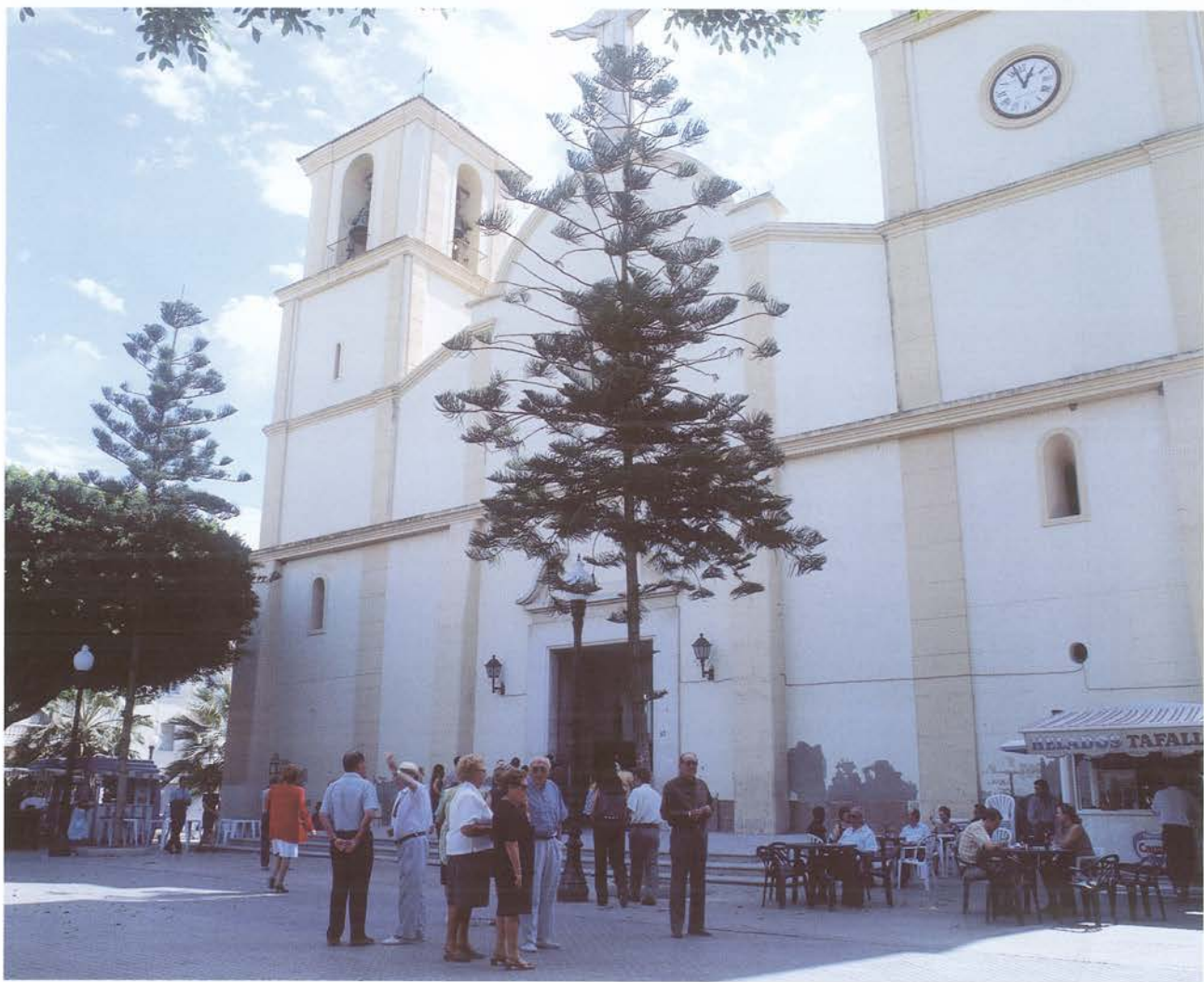
Figura 21. La prioridad dada por el superintendente de la reconstrucción y por el arquitecto a la obra civil, supuso que los edificios públicos destinados al culto se concluyesen a lo largo del siglo XIX. En la fotografía se aprecia la perspectiva de la iglesia de Almoradí a principios de la presente centuria y en la actualidad.
