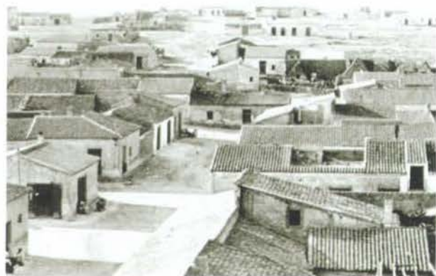
Figura 23. Una centuria después del terremoto en Torrevieja el crecimiento urbano rompió la armonía de la reconstrucción y comenzó a primar en la periferia el desorden y la anarquía urbana.
