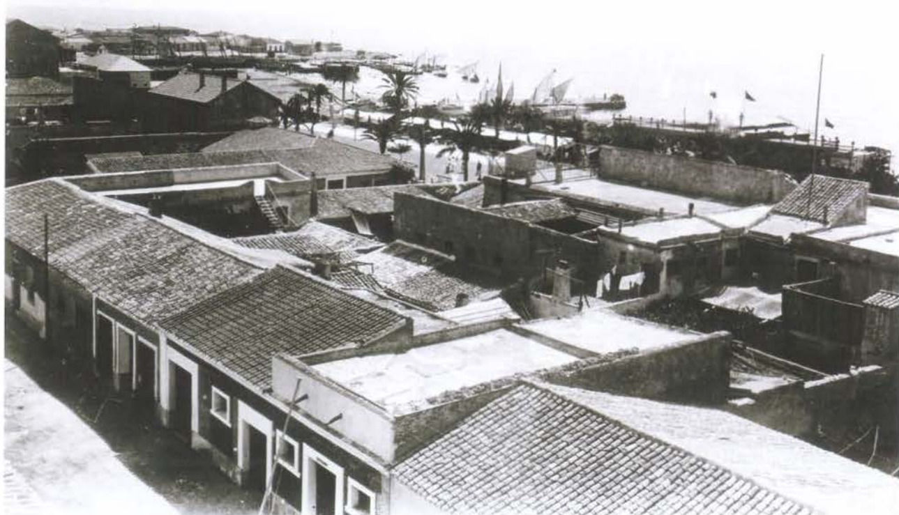
Figura 21. El tejado a una o dos aguas según el modelo de vivienda aportado por Larramendi, tardó tiempo en generalizarse; todavía se observa hacia 1910 en Torrevieja el predominio de cubiertas planas que con ligeras pendientes para la recogida de aguas pluviales eran tradicionales en la zona.
