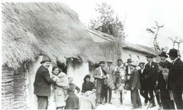
Figura 5. La barraca, construida con los materiales del entorno, era un fiel reflejo de la capacidad de adaptación del hombre al medio. Su simplicidad permitía su fácil reconstrucción después de las repetidas inundaciones del Segura, a la vez que representaba el refugio ideal contra los seísmos.
