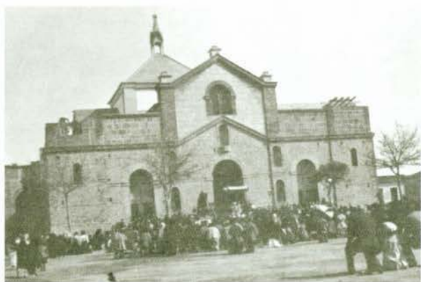
Figura 21. A finales del siglo XIX la prosperidad económica y el olvido de las catastróficas consecuencias del seísmo motivaron que las iglesias en las poblaciones de nueva planta creciesen en altura y volumen. En la imagen se aprecia la fachada de la iglesia de Torrevieja en el último tercio de dicha centuria.
