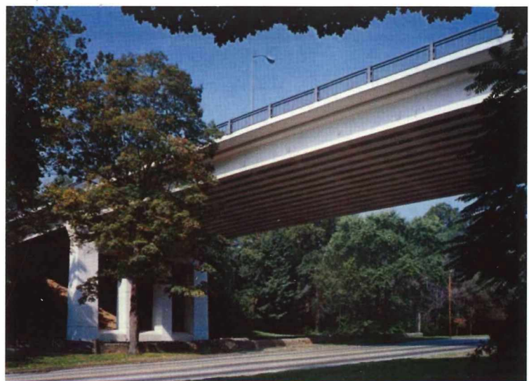
Figure 11 : Pont de la Walnut Lane à Philadelphie 1
