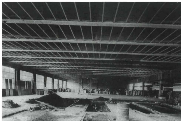
Figure 6 : Usine textile avec poutres de toiture précontraintes par post-tensioning (1947-1948) 1
