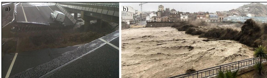
Figura 28. a) Puente de la Autovía A-70 destruido por la avenida. b) Pico de avenida de la Rambla de Nogalte a su paso por Puerto Lumbreras 28.09.2012. Fuente: La Verdad (29.09.2012).
