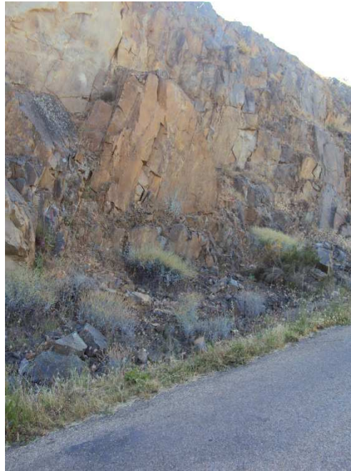
Fig. 6. Desprendimientos en el río Porquera y carretera LE-CV-160-3
