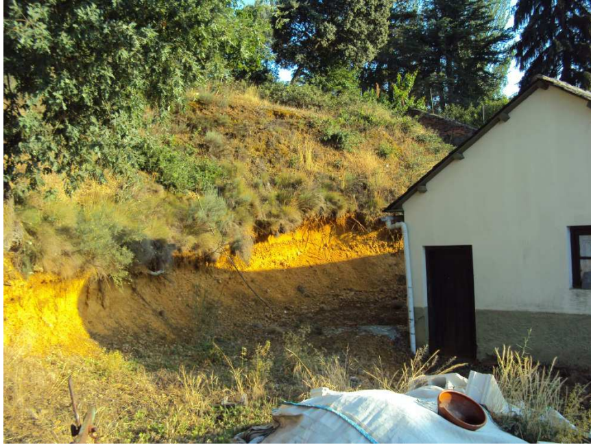
Fig. 14. Talud y edificación en Vega de Magaz.
