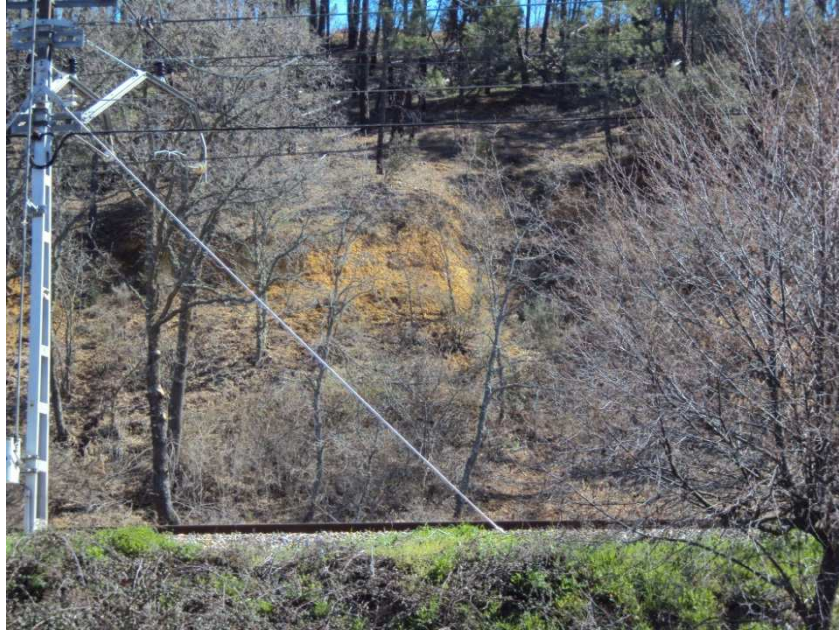
Fig. 8. Deslizamiento en Vega de Magaz
