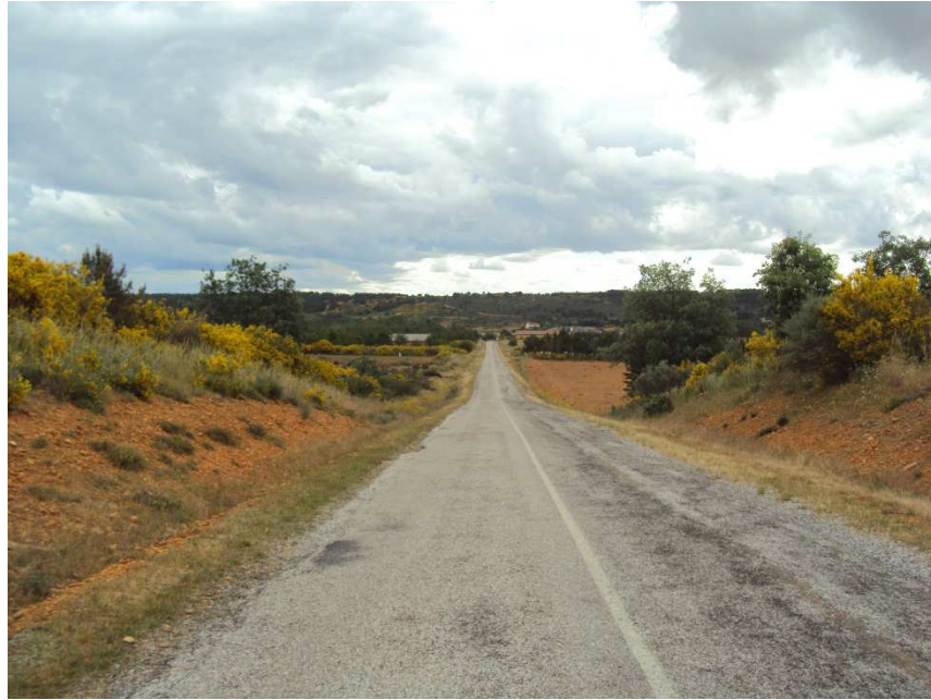
Fig. 10. Cambio de rasante entre terrazas (carretera Villamejil-Vega de Magaz)
