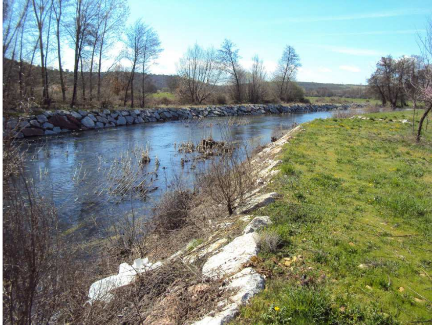
Fig. 12. Acondicionamiento del cauce del río Porquera a su paso por Vega de Magaz
