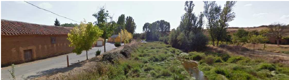
Fig. 13. Cauce del río Tuerto a su paso por Villamejil y edificaciones cercanas.
