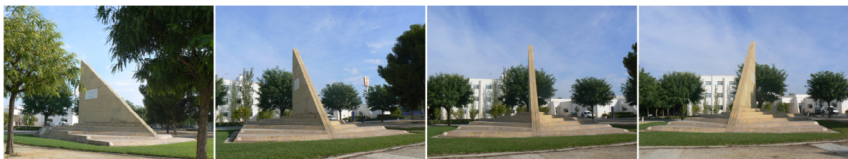
Fig. 5. Parte de la base de datos fotográfica para el levantamiento digital del reloj de sol de la Universidad de Alicante (práctica de la asignatura optativa de cuarto curso de Arquitectura técnica "Sistemas avanzados de expresión gráfica")
