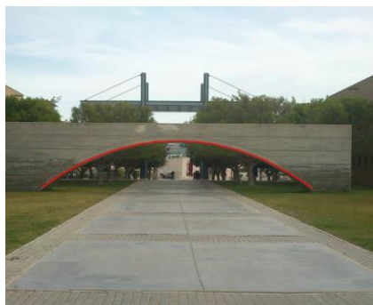
Figura 2. Catenaria de la Politécnica
