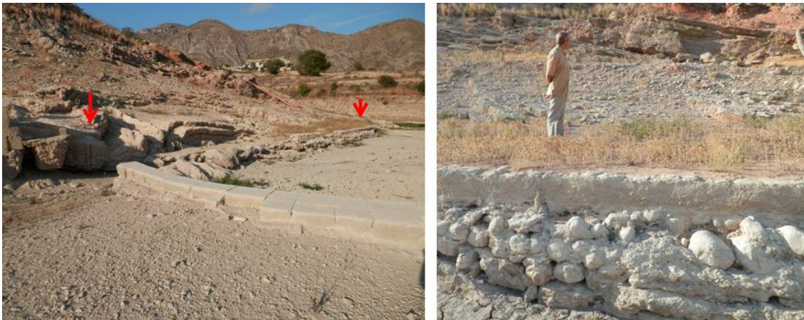
FIGURA 8. Assut de l'Amadòrio i canal que es dirigeix cap a l'assut Gran. Les fletxes assenyalen la paleta (inici del canal) i la connexió amb l'assut (final). A la dreta s'aprecien distintes fases constructives del canal.
