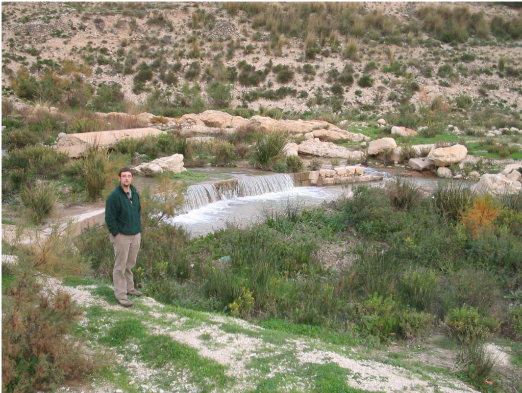
FIGURA 7. L'assut Gran en 2003, on se n'aprecia la primera part, hui soterrada pels sediments. La paleta ja té adherida una resta de l'estació d'aforament que es troba un poc més amunt, fet que no ens permet apreciar-la.
