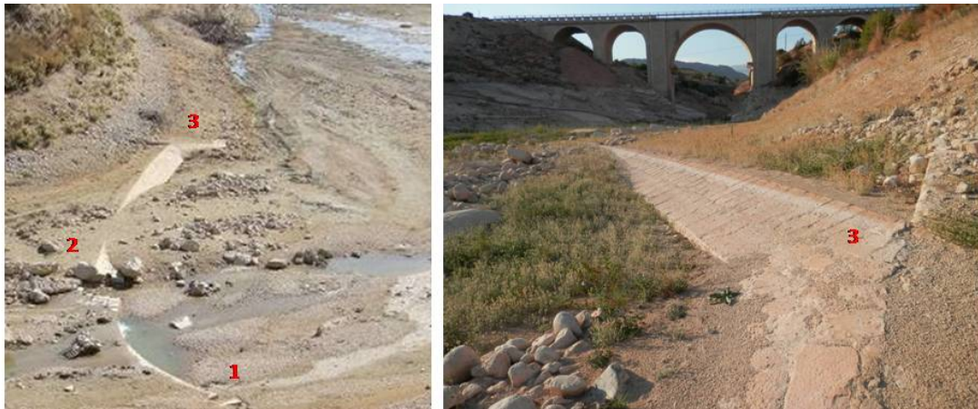
FIGURA 6. Assut Gran en 2007 (esquerra), on encara s'aprecia el sobreexidor (núm. 1, avui enrunat) i la paleta (núm. 2). A la dreta, el tancament de l'assut en 2014 (núm. 3). Fotografies de l'autor.
