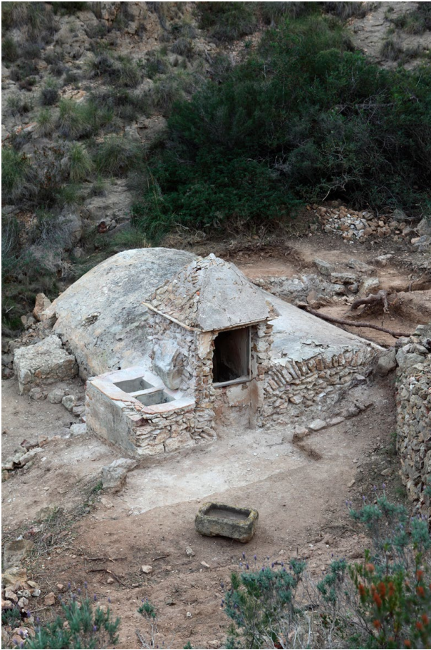
Figura 15: El aljibe durante los trabajos de restauración y puesta en valor.
