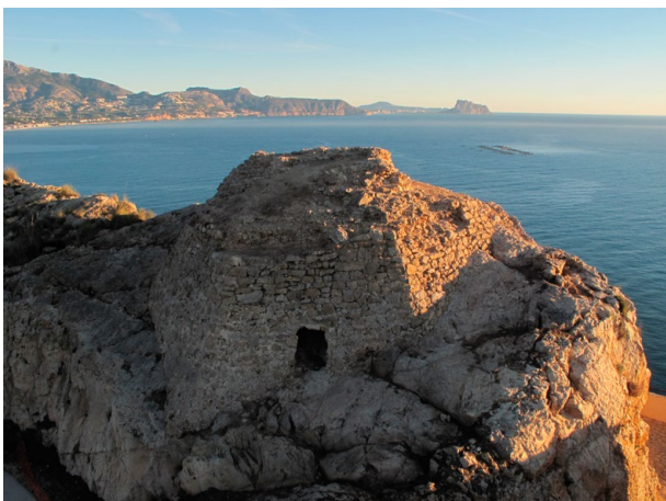
Figura 8: Vista general de la torre durante el proceso de excavación.
