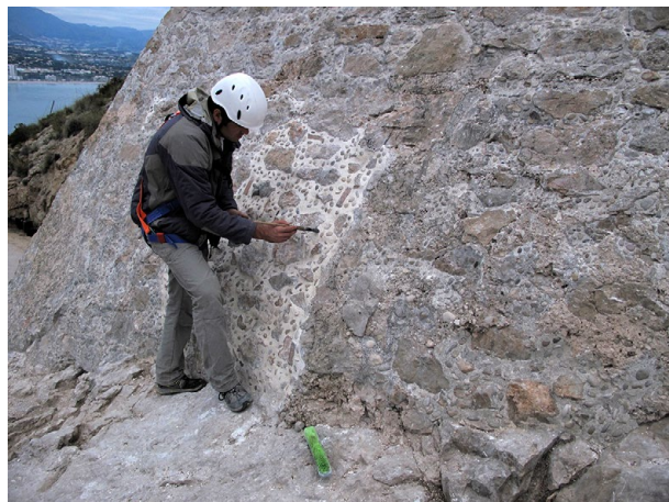
Figura 20: Tapiado del vano abierto en la fachada sureste.
