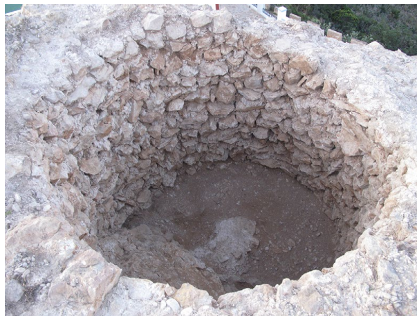
Figura 10: Cimentación del cuerpo superior.
