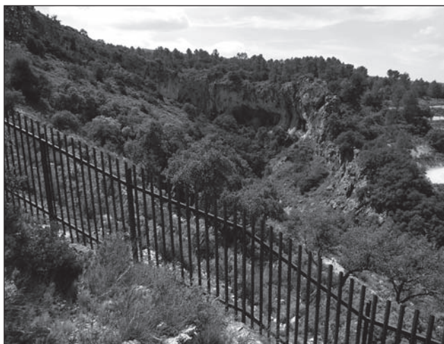
Vallado perimetral instalado en 2009.
