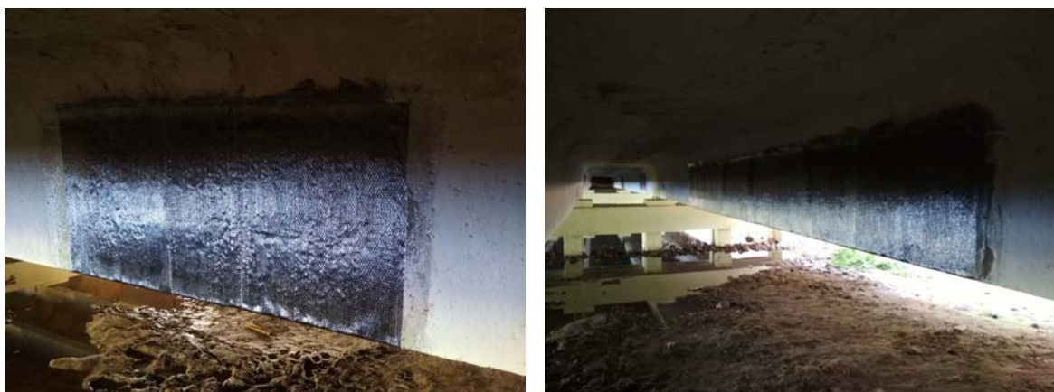
Рисунок 2 – Усиление ребра мостовой балки углеволокном
