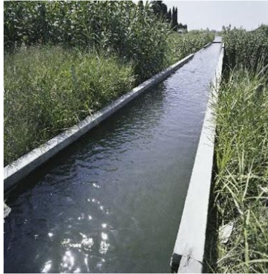
Σχήμα 2-2: Παραδοσιακό κανάλι τοιχοποιίας για διανομή αρδευτικού νερού [1].
