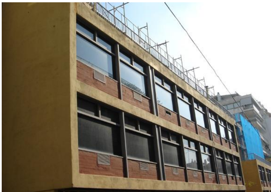
329. Το κτήριο Δοξιάδη ανήκει πια στο παρελθόν. https://www.greekarchitects.gr . 5 Δεκεμβρίου 2009
