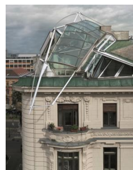
Εικόνα 23: Rooftop Remodeling Falkestrasse, Cooohimmelblau. Franz Sam
