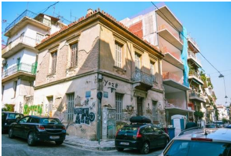
Εικόνα 5: Το υφιστάμενο κτίριο (προσωπικό αρχείο)
