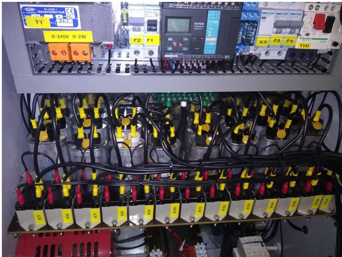
Εικόνα 34. Οι πυκνωτές στο εσωτερικό της γεννήτριας.
