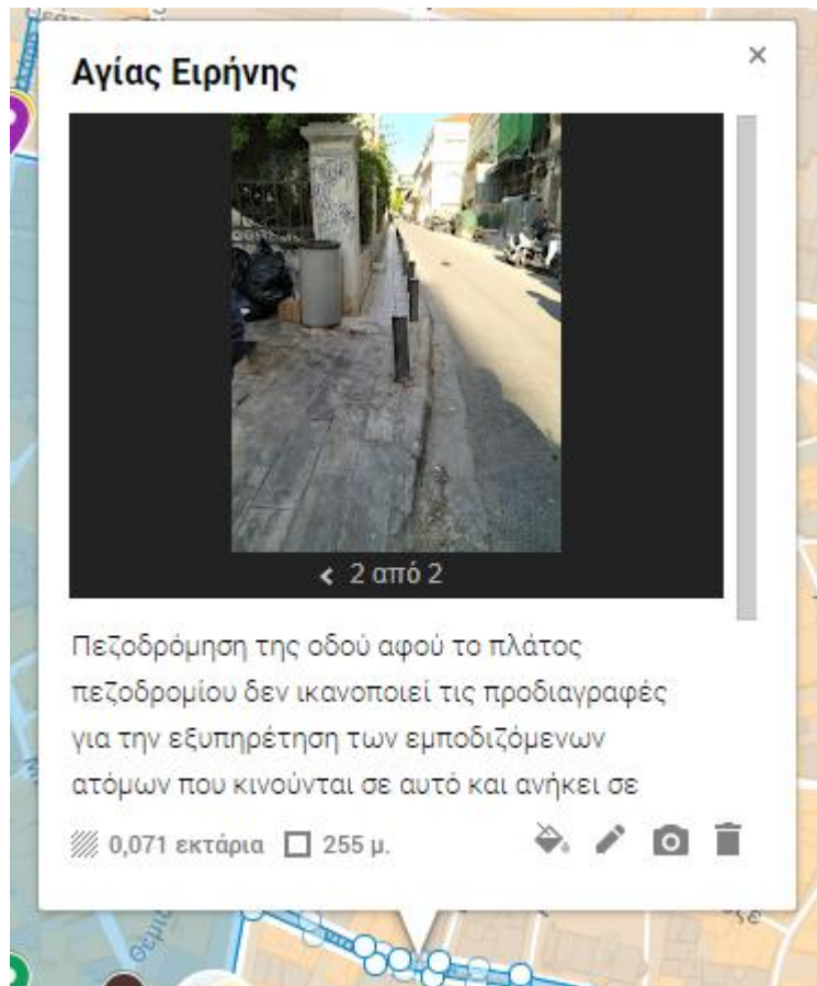
Εικόνα 5.30. Απεικόνιση της οδού Αγίας Ειρήνης από τον χάρτη καταγραφής υφιστάμενης κατάστασης.
