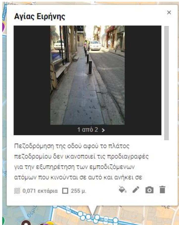
Εικόνα 5.29. Απεικόνιση της οδού Αγίας Ειρήνης από τον χάρτη καταγραφής υφιστάμενης κατάστασης.
