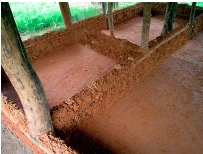
Figura 13. Piso revestido com barro compactado.
