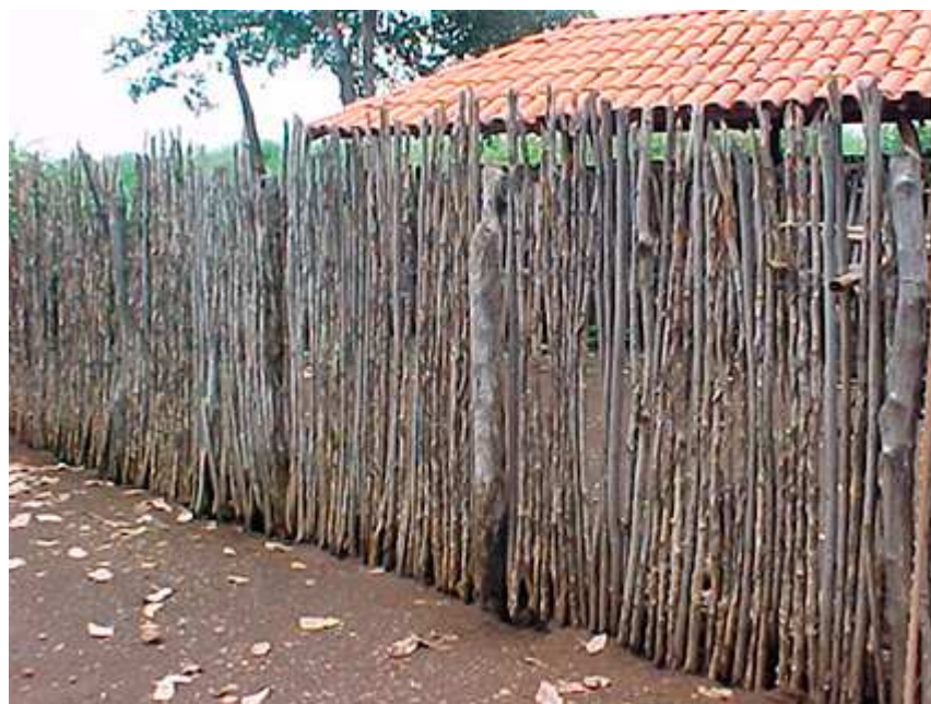
Figura 1. Cercas construídas com estacas.
