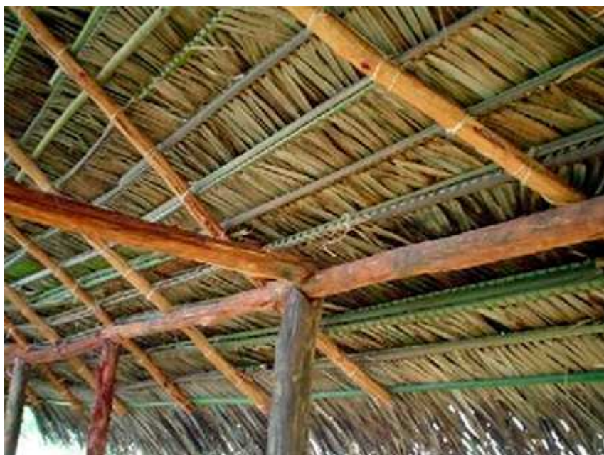
Figura 3. Cobertura do aviário feito de palha de babaçu.
