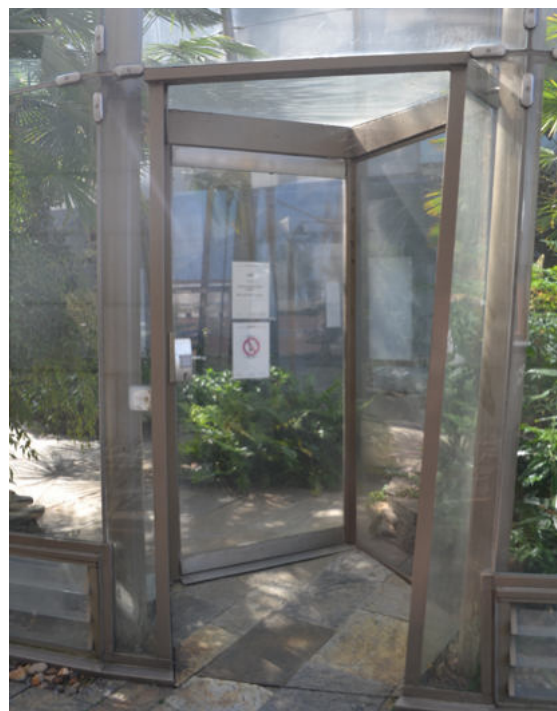
Dörren är placerad i vinkel med inåt gående dörr vilket gör det svårt att ta sig in och speciellt ut om du har hjälpmedel som rullator med dig
