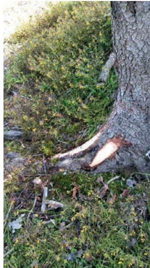
Figure 6 Damage to root and root collar Slika 6. Oštećenje korijena i žiljišta Foto: (Šarić, M.)
