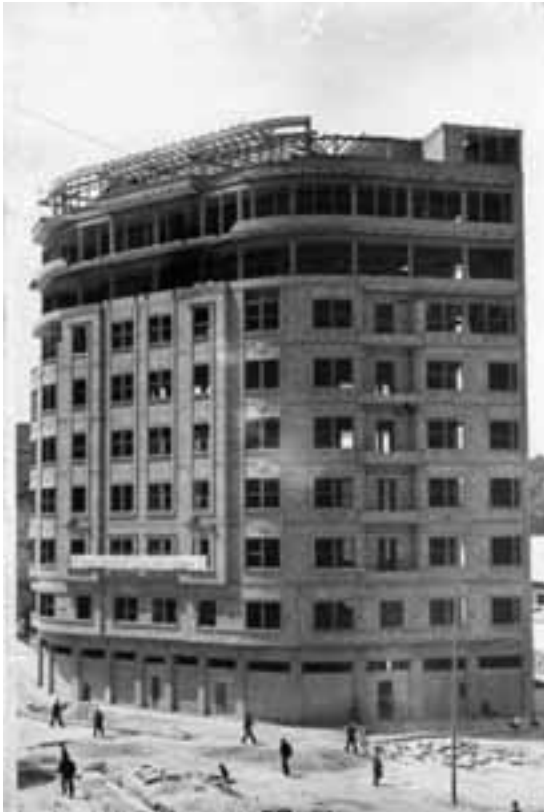
Fig. 12. Inicio de la construcción de la Avenida del Oeste. Edificio de Sindicatos.
