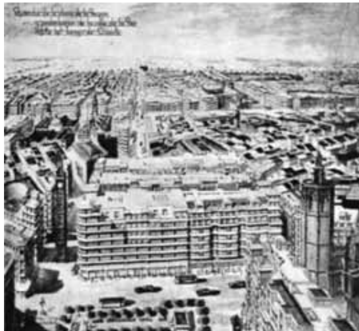
Fig. 8. J. Goerlich. Proyecto para la Plaza de la Reina . Revista Administración y Progreso, nº 39. Agosto, 1935.
