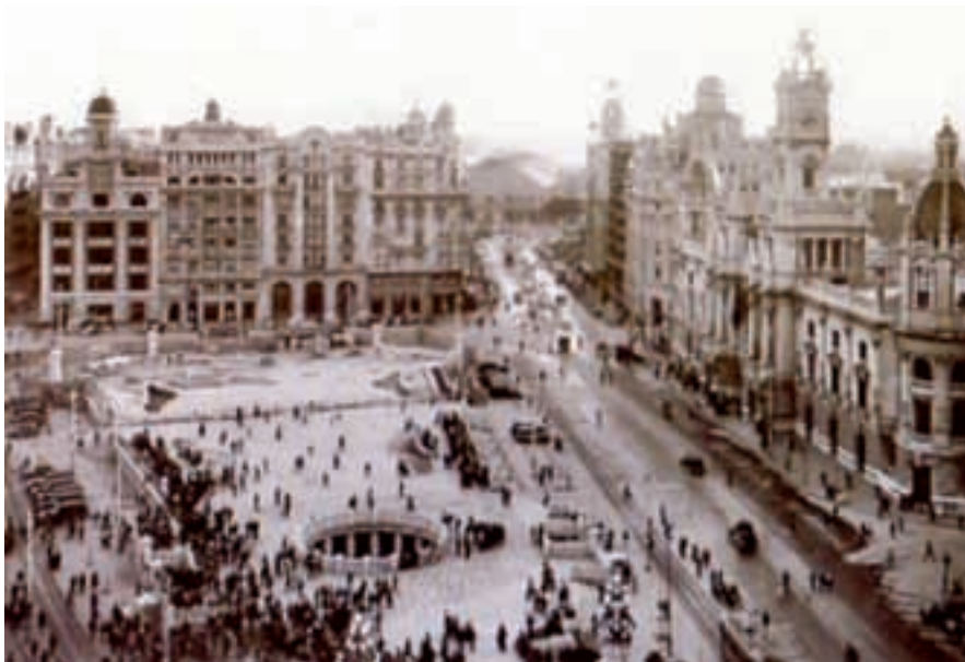
Fig. 5. Plaza del Ayuntamiento. El macizo central, en obras, en 1932. Archivo José Huguet.
