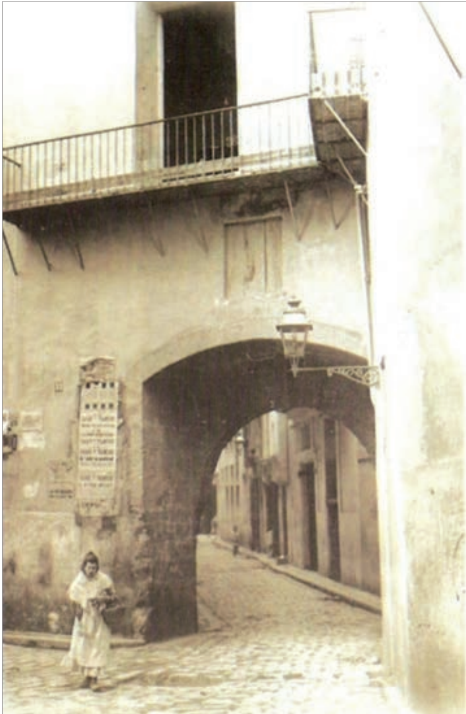
Fig. 1- Aspecto del intradós del portal, antes de la intervención.
