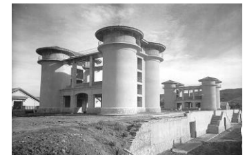
fig. 6.31.a|b|c. Diferentes fases de la construcción de las instalaciones destinadas a Granja-Escuela.
