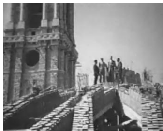
fig. 5.51. a|b|c. Diferentes fases de la construcción de los arcos de la bóveda que cubre la nave central.
