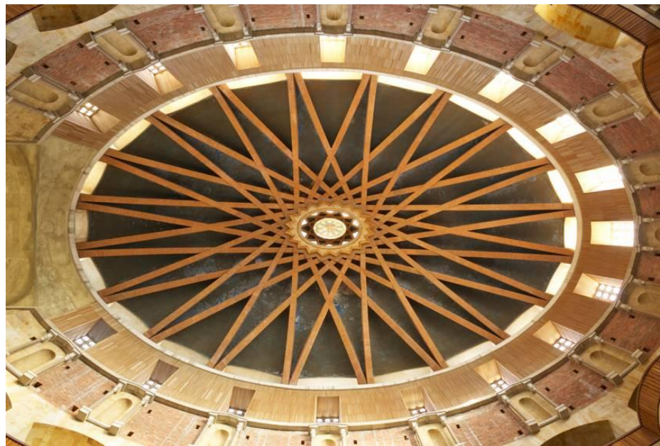
fig. 5.50. Imagen de la cúpula que cubre la iglesia.
