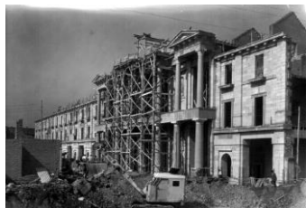
fig. 5.54.a | b. Diferentes fases de la construcción de la fachada del Teatro.
