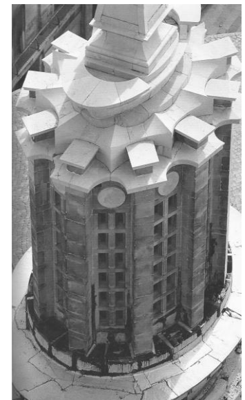
fig. 5.40.a | b. Imágenes del linternón en proceso de ejecución, con el anillo que enlaza los arcos tabicados e imagen exterior final.
