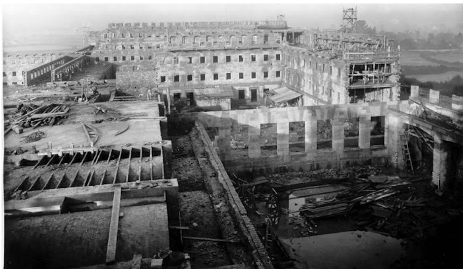
fig. 5.62. En primer plano podemos observar el sistema de bóvedas tabicadas que Luis Moya utilizaría profusamente durante toda su obra. El dominio del sistema queda patente en la disposición de las lengüetas de rigidización de la cáscara.
