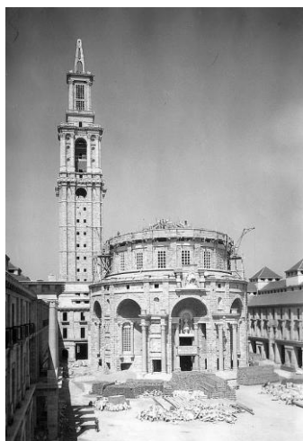
fig. 5.30.a|b|c|d. Proceso de construcción del volumen exterior en el que se puede apreciar el juego de volúmenes y texturas del tambor inferior.
