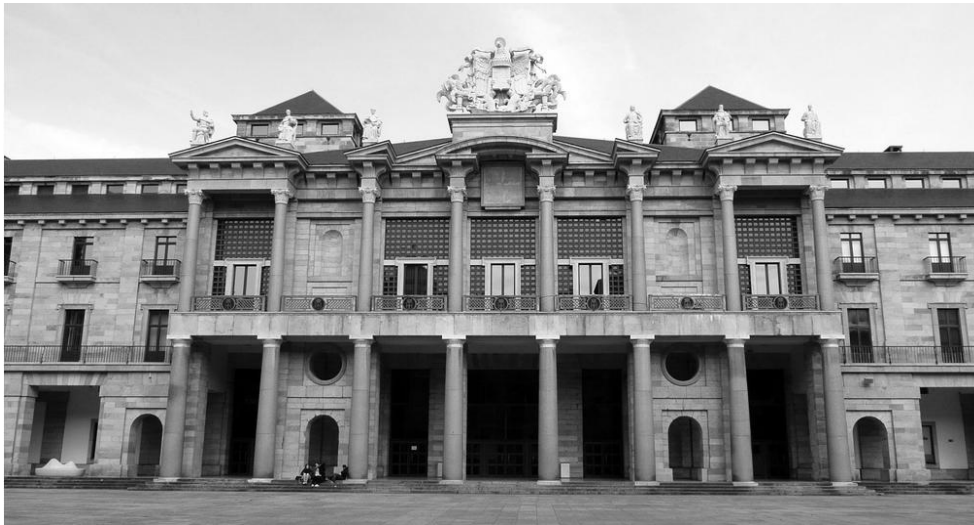
fig. 5.55. Imagen de la actual fachada tras la reforma llevada a cabo por la Consejería de Cultura del Principado (2005-07)
