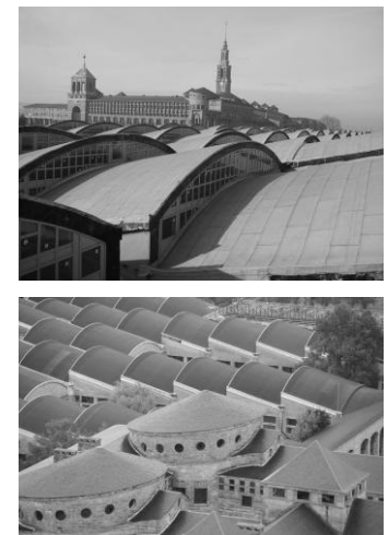
fig. 5.78.a | b. Vista de las cubiertas de los talleres en las que se aprecian las bóvedas cilíndricas en forma de diente de sierra.
