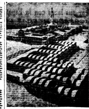
La obra social de la Universidad Laboral de Gijón, que está siendo construida por los obreros de la propia obra.
