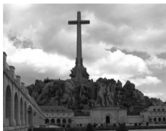
fig. 2.2.a|b|c Fases de construcción de la Cruz del Valle de los Caídos, una de las primeras obras del régimen, comenzada en 1940 y terminada en 1958
