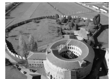
fig. 6.35.a | b. Construcción y estado actual de las construcciones que ocuparon las Clarisas.
