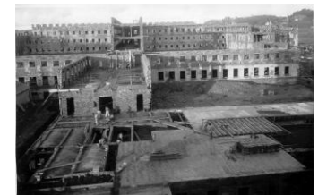
fig. 5.12.a|b|c|d. Diferentes fases de la construcción de los frentes de Fachada.
