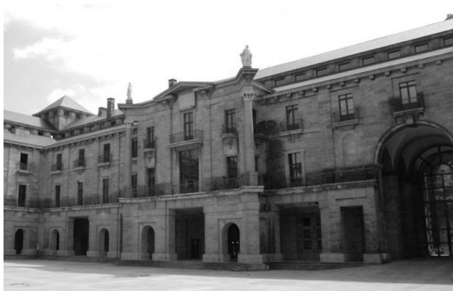
fig. 5.66. Fachada de acceso al Edificio de Dirección, junto al "vestíbulo" que constituye el Atrio Corintio.
