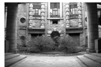
fig. 5.25.a | b. Soportales que rodean toda la Plaza y que permiten el recorrido al resguardo de las inclemencias meteorológicas.
