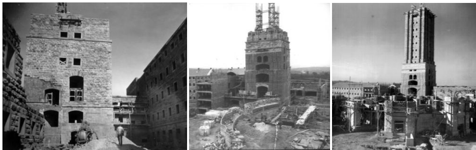
fig. 5.85. a|b|c. Diferentes etapas de la construcción de la torre.
