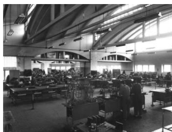
fig. 5.81. a | b. Vista de la zona de entrenaves en el interior y en el exterior de las mismas.
