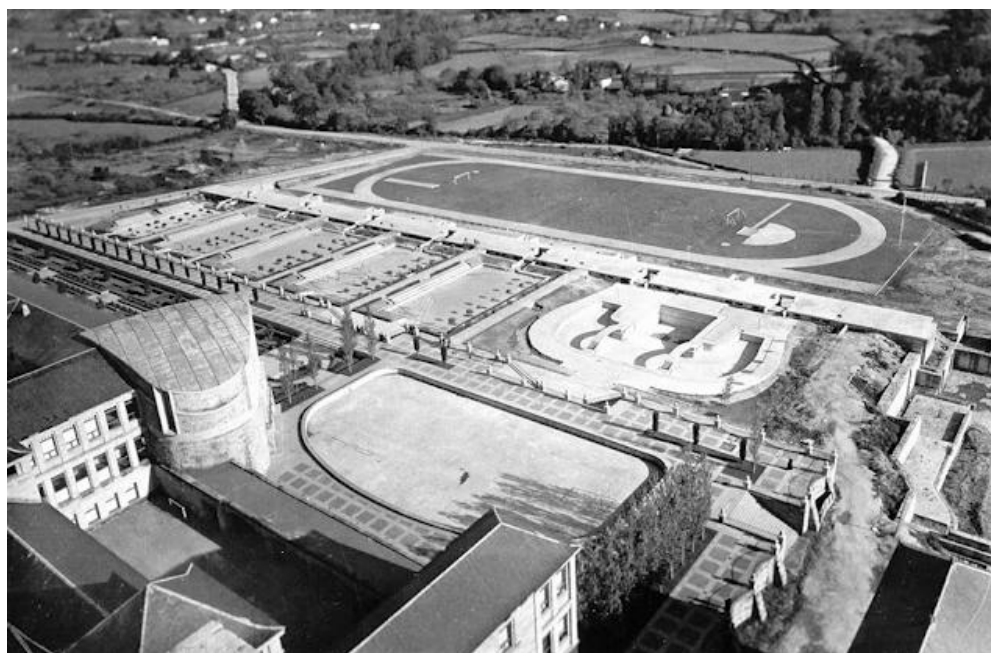
fig. 6.25. Imagen tomada desde el mirador de la torre hacia la zona deportiva situada en la Fachada sur de las edificaciones principales, y en la que se pueden ver las canchas deportivas junto con la piscina.
