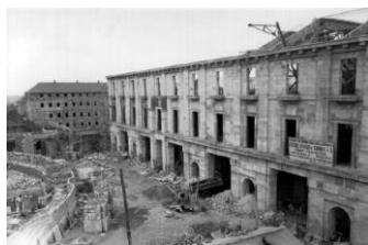
fig. 5.23.a | b | c. Diferentes fases de construcción de las edificaciones perimetrales al Patio central.
