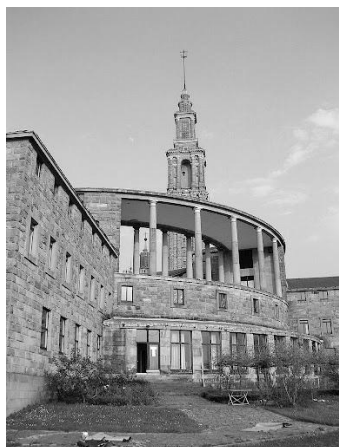
fig. 4.20.a | b | c. El Convento y las dependencias destinados a las monjas clarisas que se encargarán del cuidado de los jóvenes se encuentran conectadas con el edificio principal por un mínimo pasillo.
