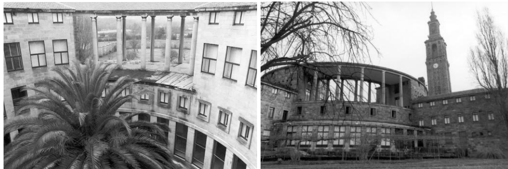
fig. 6.37.a|b. La planta circular condiciona los espacios interiores y exteriores.
