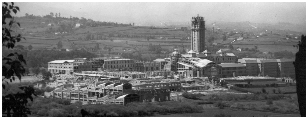
fig. 5.79. Imagen de la construcción de la Universidad Laboral en la que se ve la zona de talleres situados al nordeste del edificio principal.
