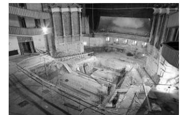
fig. 5.61.a | b. Imágenes de la construcción original en torno al año 1951 y de la reforma interior y reconstrucción parcial exterior realizada entre los años 2005 y 2008.
