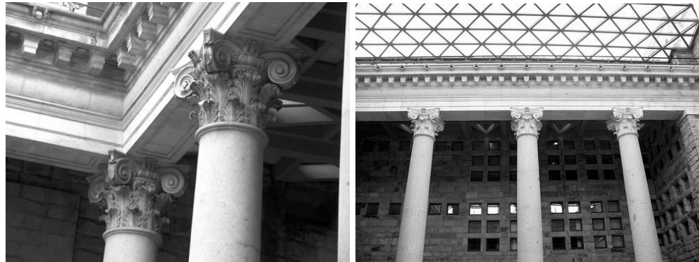
fig. 5.17.a | b. Dos detalles de los capiteles y del entablado que corona superiormente la columnata.
