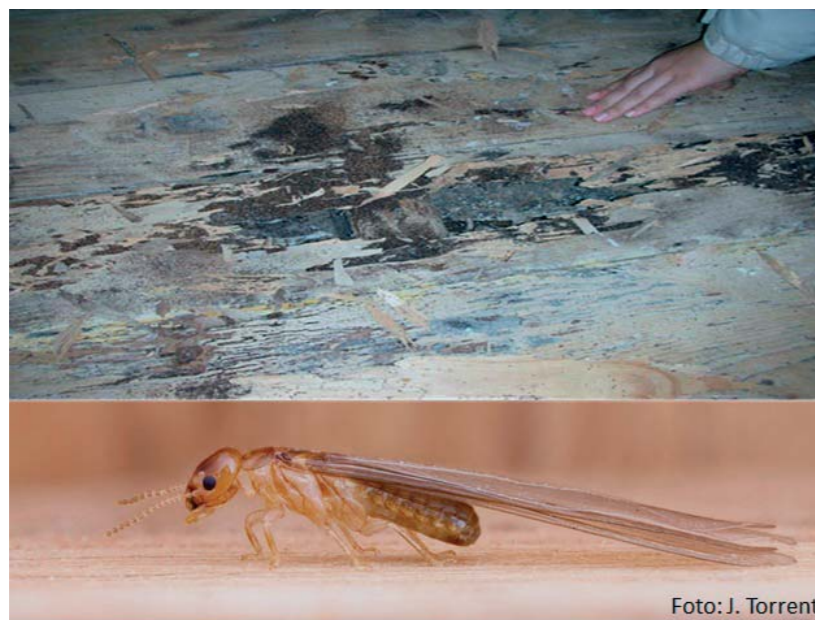
Figura 1. Exemplo do dano causado pela térmita Cryptotermes brevis (acima). Imagem de um alado de C. brevis (abaixo)
