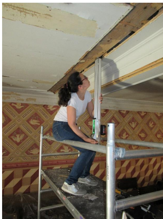
Figura 38 - Execução de ensaio com resistógrafo na viga VI
