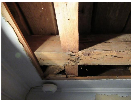
Figura 36 - Pormenor do travamento com elemento na diagonal
