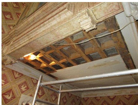
Figura 10 - Suporte do Pavimento do piso 1 da Tribuna
