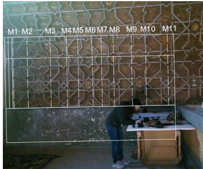
Figura 31 - Localização dos montantes no painel Norte
