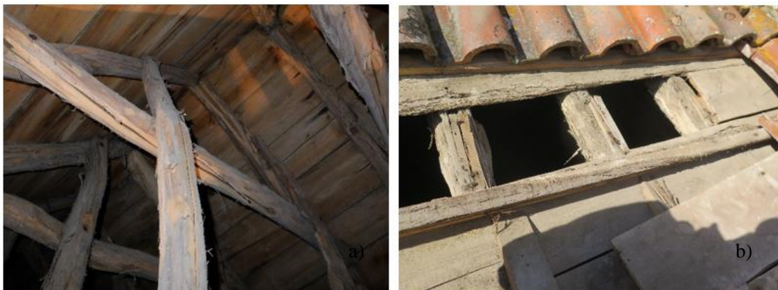
Figura 5 - Estrutura da cobertura: a) asna; b) pormenor da cobertura pelo exterior – (NCREP, 2018)
