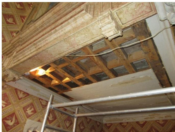
Figura 35 - Vigas da Tribuna
