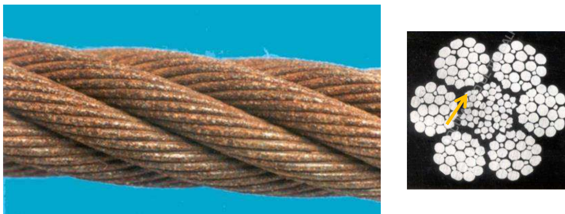
Figura 10 – Cabo com corrosão externa, à esquerda, e interna, à direita (Adap. de ISO 4309:2004)
