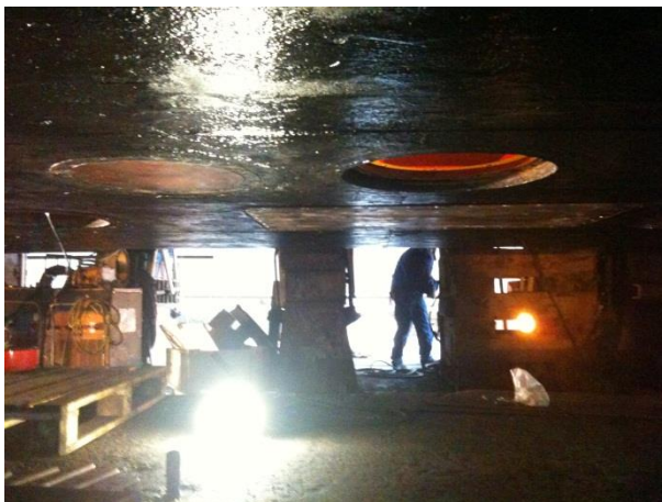
Abb. 19.2: Unterseite des Schiffbodens von FS 'Polarstern' mit den Eisschutzfenstern für die Simrad EK60 Sendewandler. Links mit installiertem Eisschutzfenster, rechts mit entferntem Eisschutzfenster.
