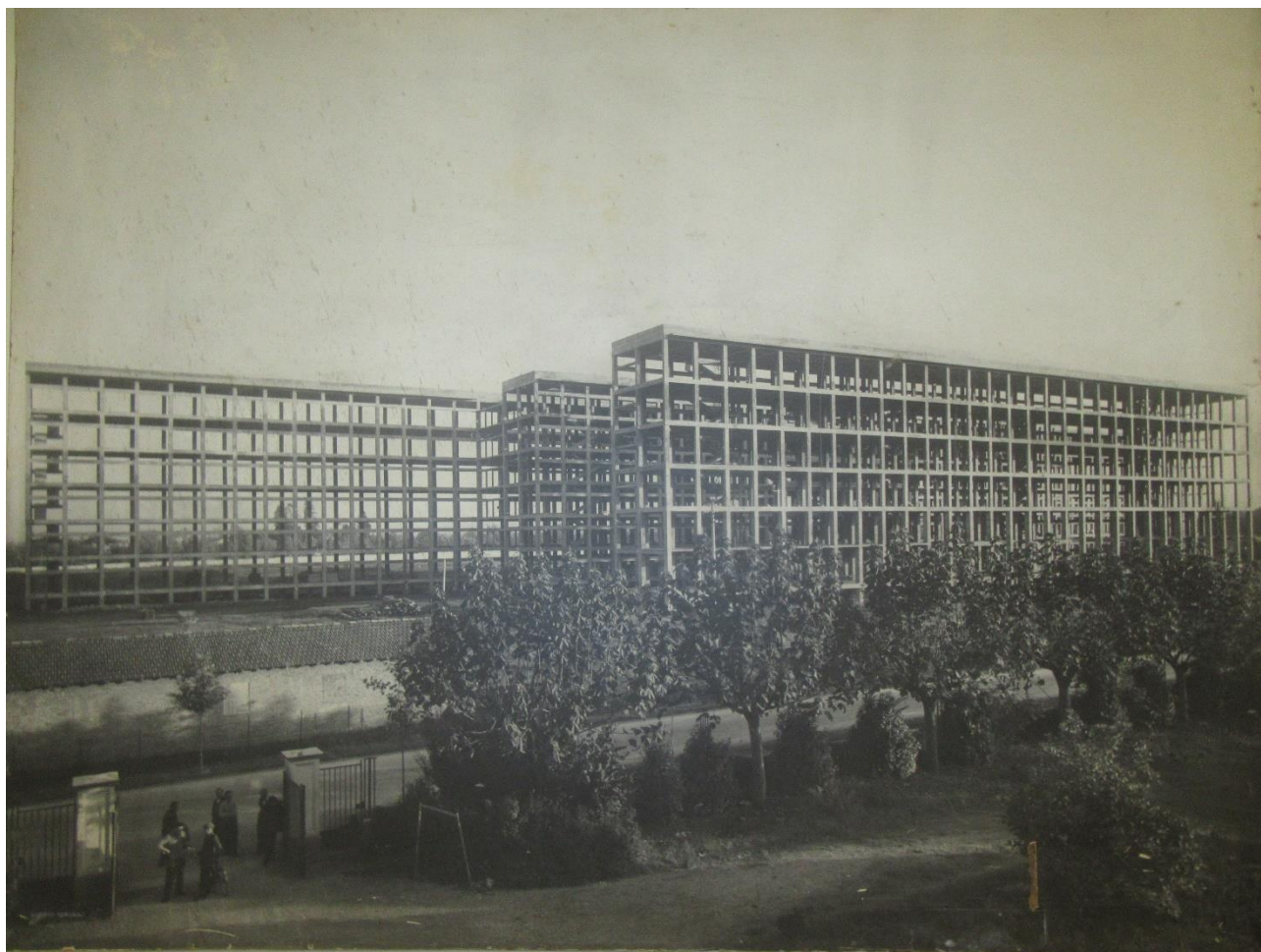
Figura 4.2.3 Scheletro della struttura dell’Arcispedale, rimasto esposto alle intemperie dal 1952 al 1956.
