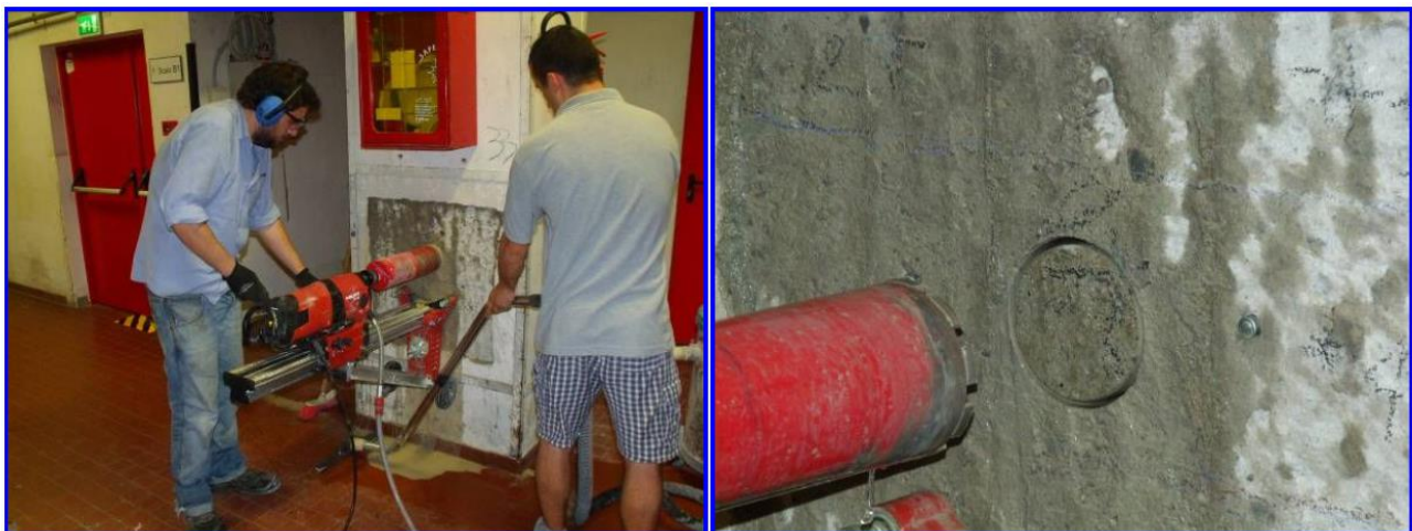
Figura 4.2.18 Estrazione della carota di calcestruzzo.
