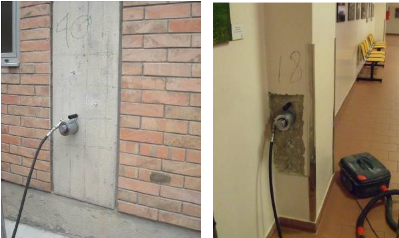
Figura 4.2.10 Prove di Pull-out: a sinistra su un pilastro esterno, a destra su un pilastro interno.
