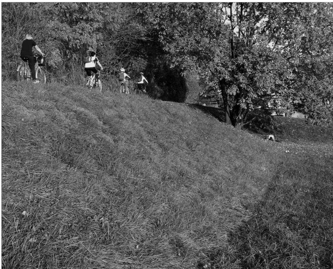
Ryc. 2. Wał przeciwpowodziowy w Krakowie. Skarpa nasypu, która nie jest zalewana wodami od góry. Wody opadowe spływające po skarpie jej nie erodują – nie są widoczne jakiegokolwiek bruzdy erozyjne, pomimo że nasyp jest stary (kilkadziesiąt lat). Fot. B. Rzonca
