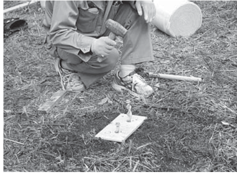
写真 57 スパイラル杭打ち込み作業の様子
