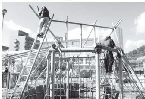
写真 62 葛蔓緊縛作業の様子
