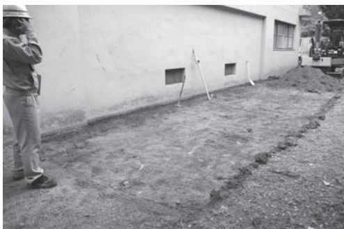
38-5 2区掘削後(北東より)
