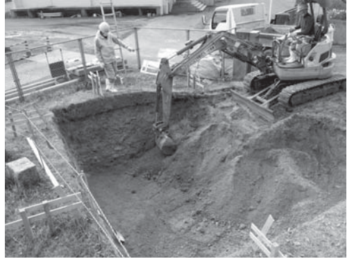
36-2 掘削状況（北西より）
