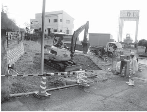
36-1 調査区全景（南西より）
