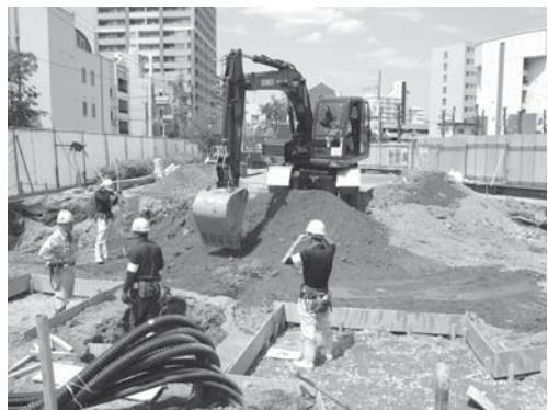
32-6 10区掘削状況（南より）
