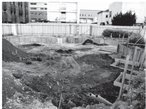
33-6 10区掘削終了状況（東より）
