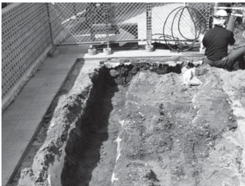
32-3 外構工事地区（3・5～9区掘削完了状況） （北東より）
