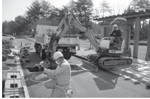
31-2 掘削状況（西より）
