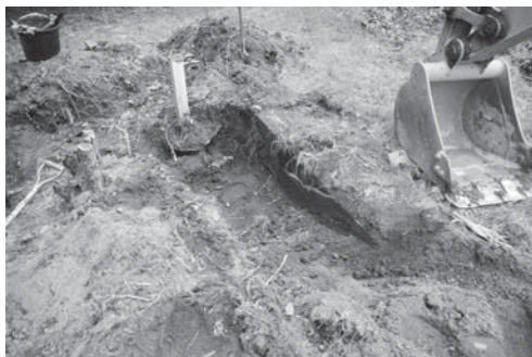
38-4 1区掘削後(南西より)
