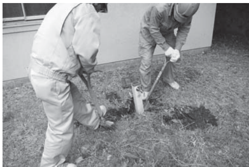
38-2 1区掘削後(南東より)
