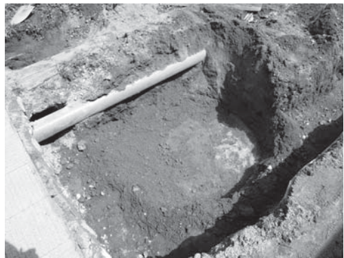
32-4 6区兵器支廠造成土露出状況（南より）
