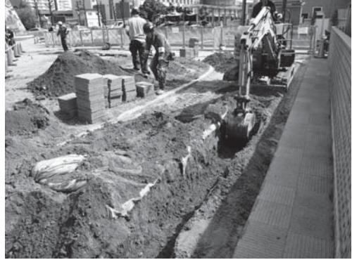
32-2 5区掘削状況（南西より）
