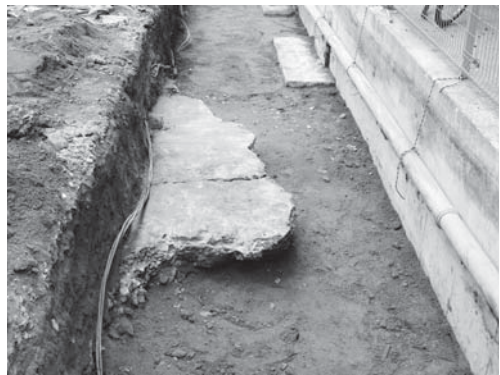
19-4 コンクリート床2検出状況（北より）
