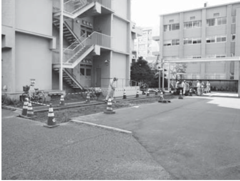
10-1 駐輪場E全景（北西より）
