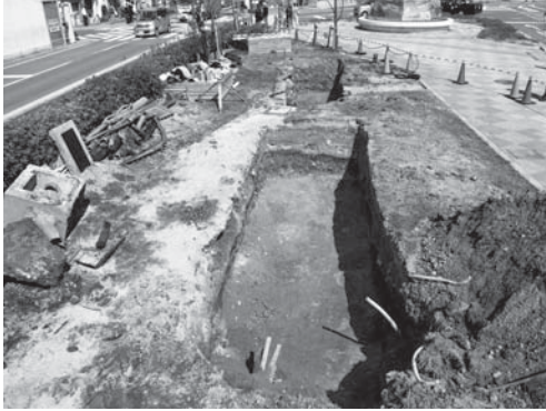
22-1 1区北半部完掘状況（北より）
