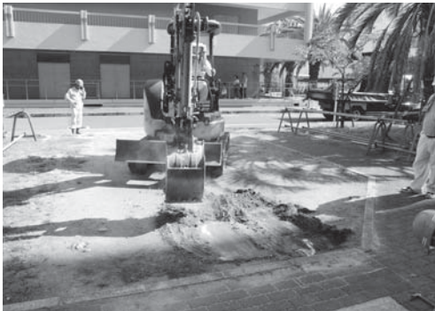
7-1 駐輪場C表土漉き取り状況 (北より)
