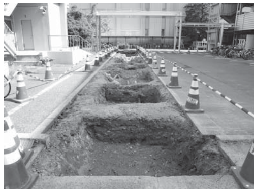
11-4 駐輪場E完掘状況(北より)
