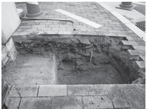
12-6 6区完掘状況（北より）
