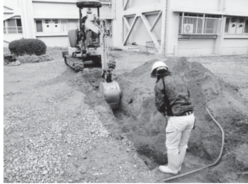
14-2 1区掘削状況（南より）
