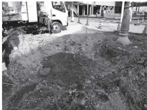
13-6 4区完掘状況（南西より）
