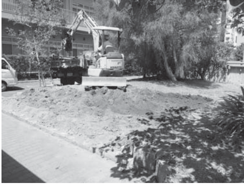
8-1 駐輪場D表層土漉き取り状況（南東より）
