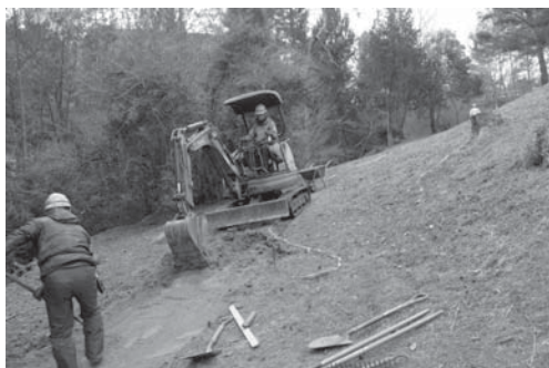
6-1 歩道掘り方掘削状況（東より）
