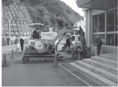
25-2 1区掘削状況（南西より）
