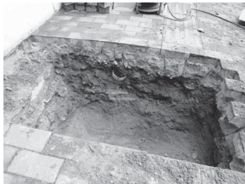
12-4 3区完掘状況（北より）
