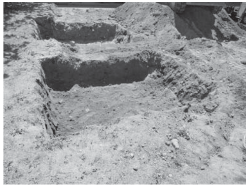
8-4 駐輪場D・18区掘削状況（北より）
