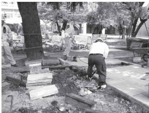
24-2 掘削状況（南西より）
