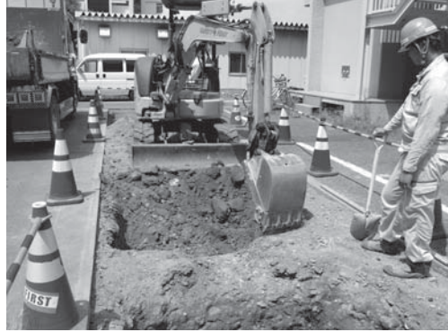
10-2 駐輪場E屋根支柱基礎掘り方（7区）掘削状況（北より）
