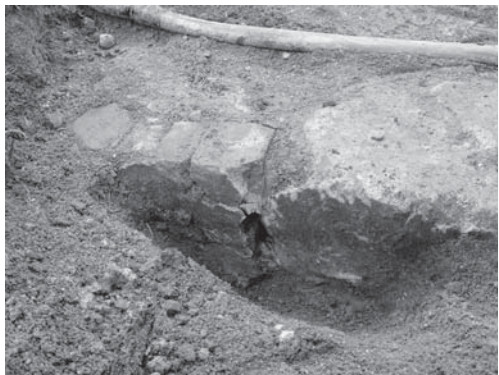
14-4 1区コンクリート床、煉瓦組遺構構築状況（北より）
