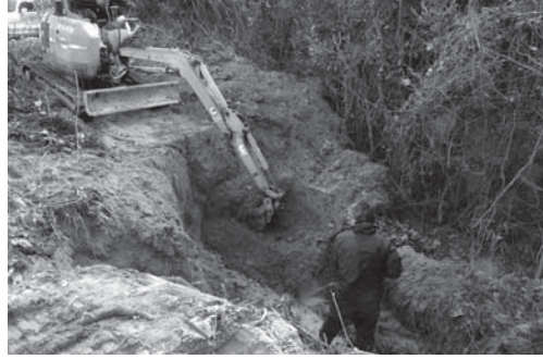
4-2 給水管および漏水箇所探索状況（西より）
