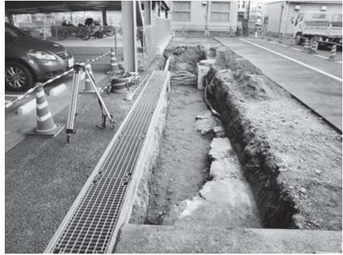
19-2 コンクリート床1検出状況（南より）
