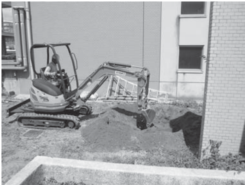
9-3 駐輪場D・25区（高木移設先掘り方）掘削状況（南東より）
