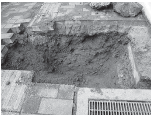
12-5 4区完掘状況（南より）
