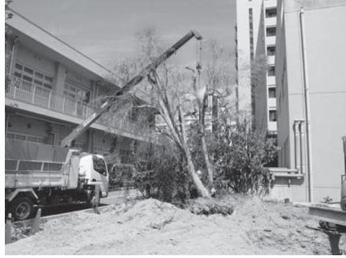
9-2 駐輪場D高木移設状況（南より）
