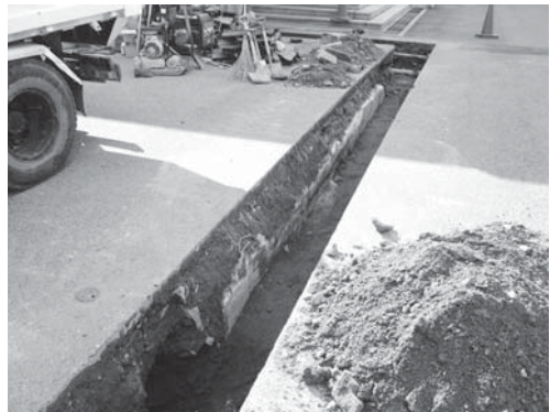
25-4 2区東西コンクリート壁検出状況（北東より）
