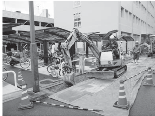
21-2 掘削状況 (南西より)
