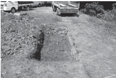
2-5 6区完掘状況（南東より）
