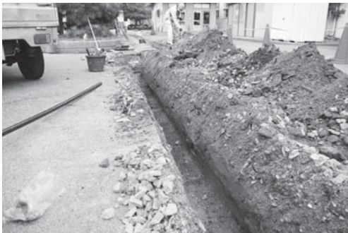
26-3 3区掘削風景（東より）
