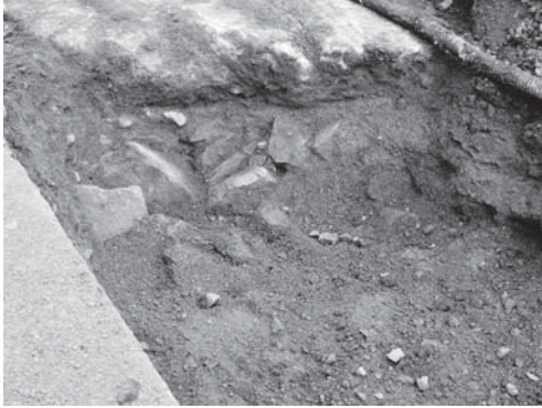
17-1 1区コンクリート床西端部構築状況（北西より）
