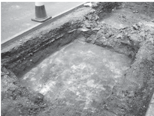
10-5 駐輪場E・4区コンクリート床検出状況（南東より）
