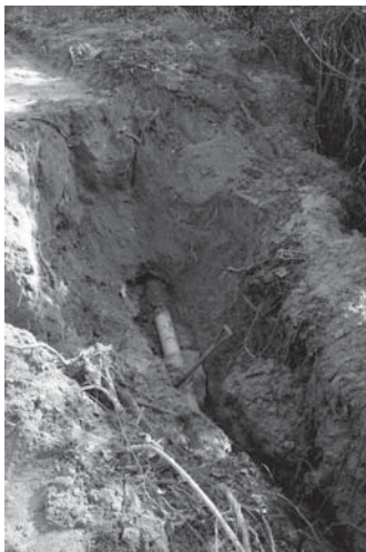
4-3 給水管応急処置状況（西より）
