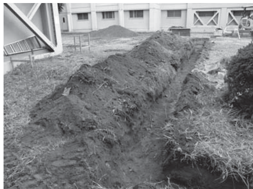
14-6 1区完掘状況（北より）
