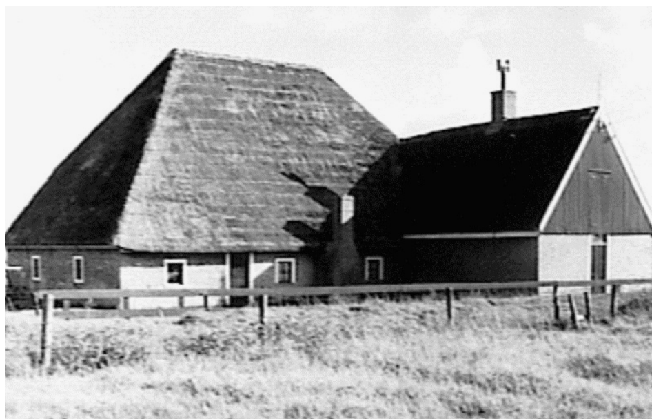
Afbeelding 5: Een Fries huis in Stroe op Wieringen met een dwars aangebouwde schuur (Rijksdienst voor het Cultureel Erfgoed)
