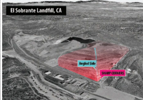
[6] Landfill configuration: El Sobrante Landfill, CA (Zhong 2019).
