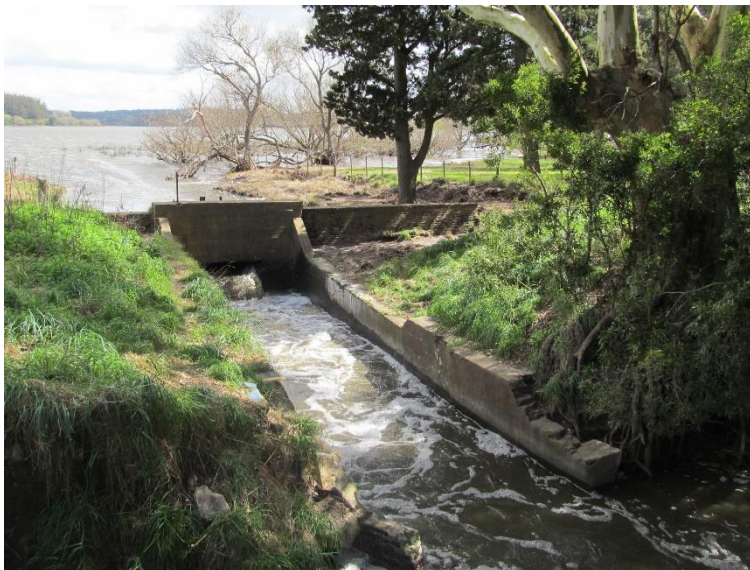
Figura 4.12. Compuerta del A° La Tapera.
