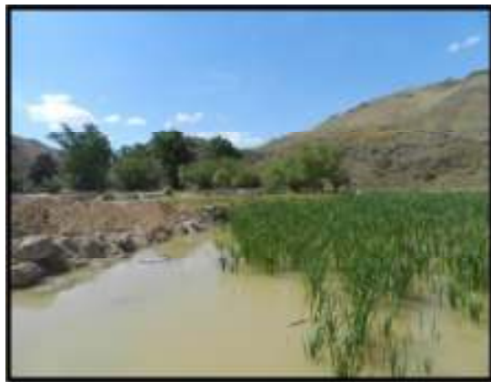
Figura 12. Piletas de decantación vegetadas Foto Favio Pollo
