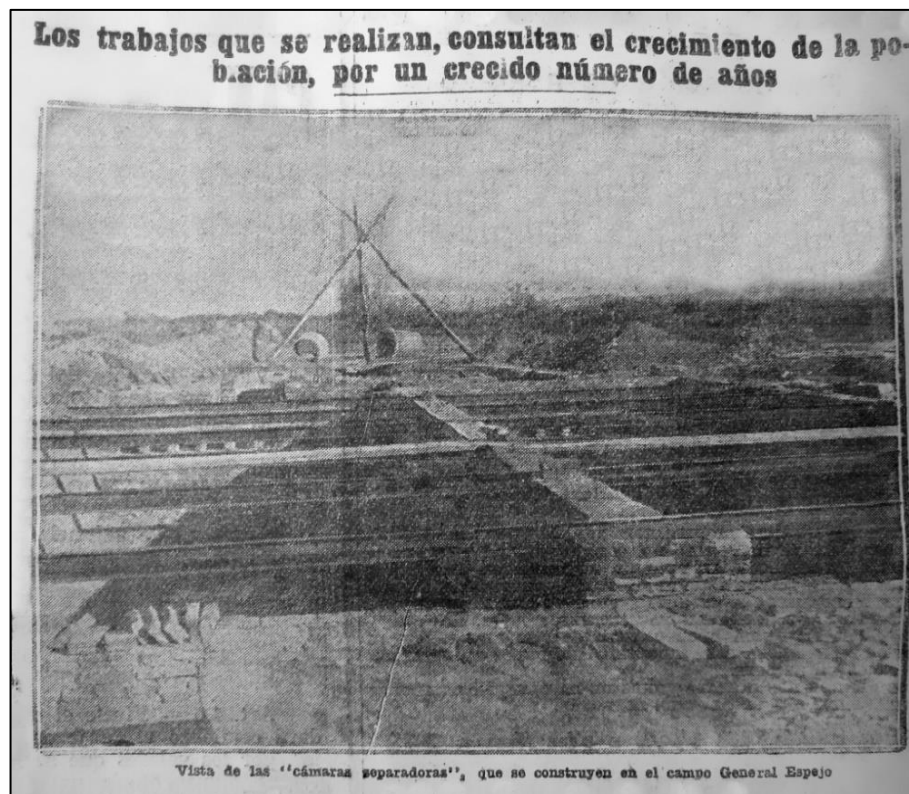
Figura 20 - Trabajos de la red cloacal. Mendoza-1924
