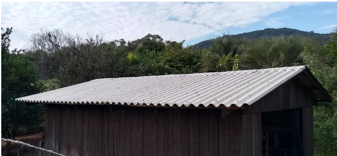
Figura 20 – Telhado de fibrocimento para fixação dos módulos na área rural
