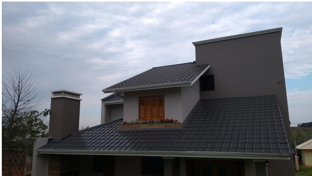
Figura 26 – Telhado cerâmico para fixação dos módulos na área urbana
