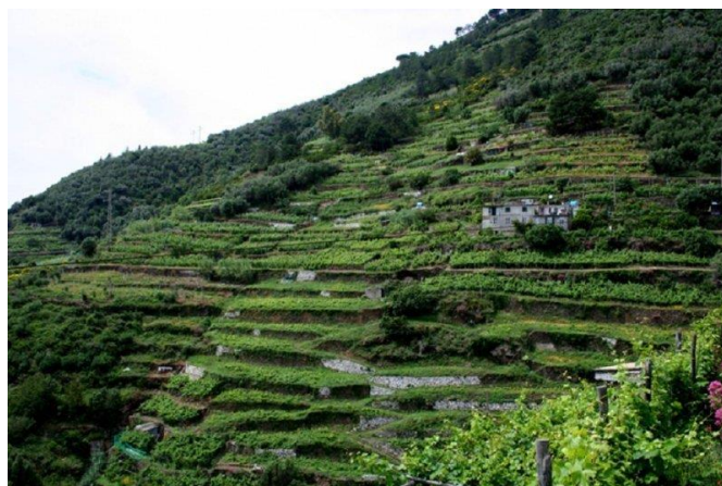
Figura 5 – Vista di un tipico versante del bacino di Vernazza artificialmente terrazzato nella porzione inferiore, occupato dalla macchia mediterranea spontanea nella parte sommitale.
