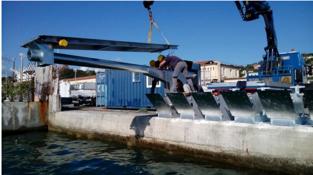
Figura 5.11 – Installazione moduli mobili mediante gru
