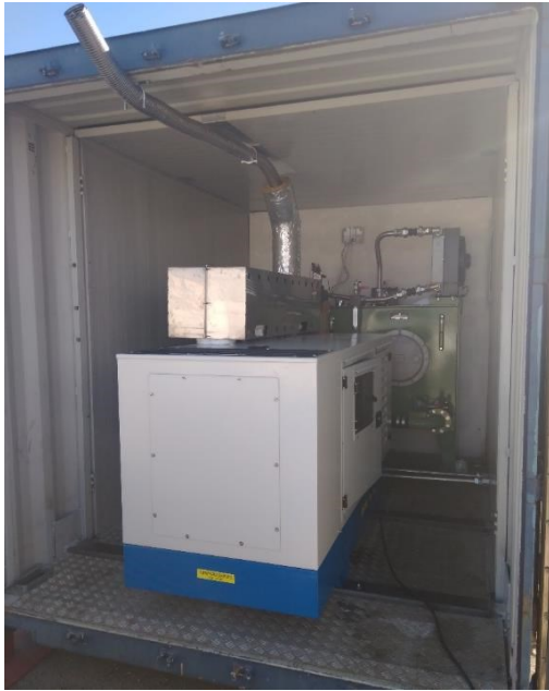
Figura 5.13 – Vista dell'interno del container – motore e pompa idraulica
