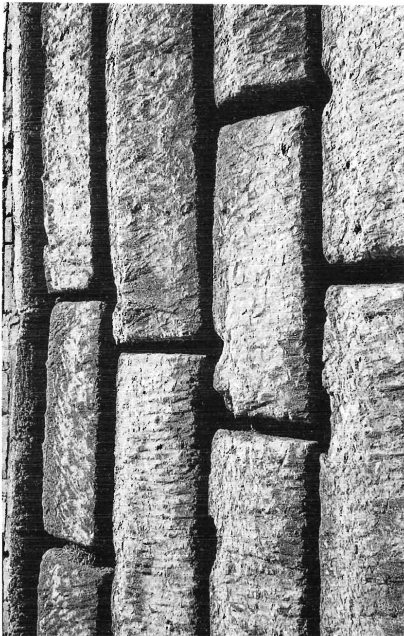
2. Bologna, torre della Garisenda, particolare della lavorazione
