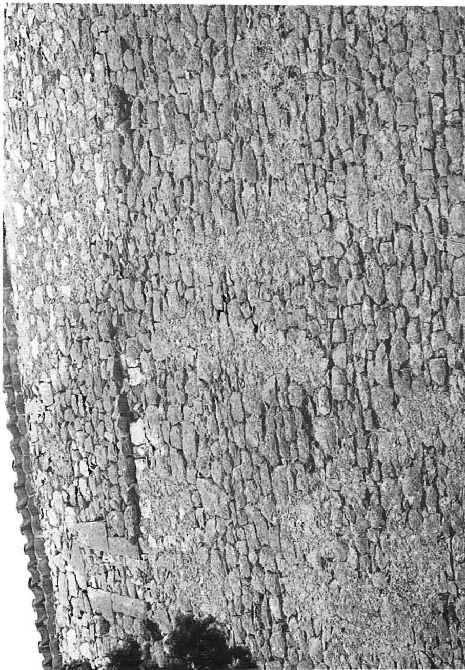
5. Alatri, Monastero di S. Sebastiano, chiesa, parete N, particolare di finestra tamponata
