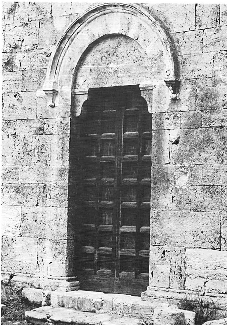
6. Ferentino, S. Maria Maggiore, esterno, portale con mensole di sostegno per il timpano
