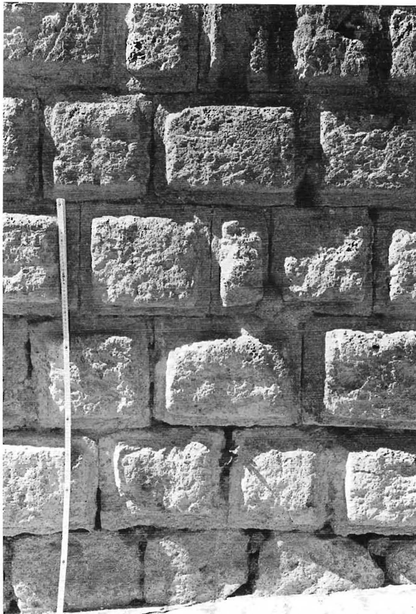
6. Toscana, torre in via Cavaglione, particolare della muratura
