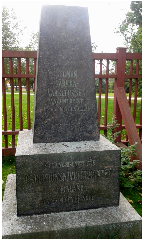
FIGURE 7.2. Height reference pillar in the garden of the Helsinki astronomical observatory in Kaivopuisto, Kääriäinen (1966) . Text:
